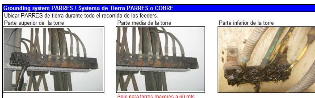
Figura 37. Sistema de tierra para barras de cobre.
