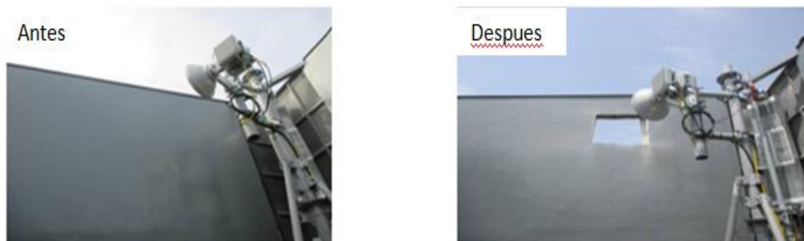
Fig. 58 Enlace microondas incidiendo sobre mimetizado. (Elaboración propia)
