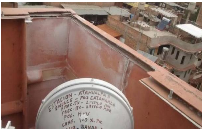
Fig. 59 Enlace microondas incidiendo sobre mimetizado, mimetizado raspado. (Elaboración propia)
