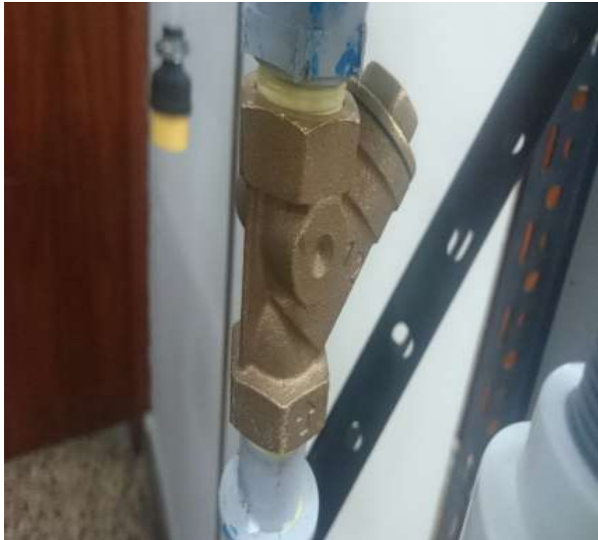
Figura 2.13: Válvula Check tipo Y.
