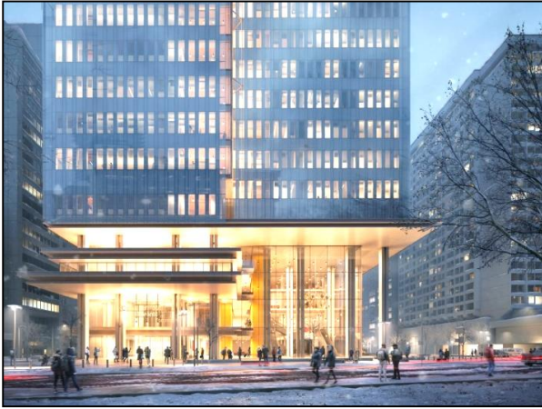
Imagen 9 - Hall de Ingreso en triple altura, recuperado de http://www.rpbw.com/project/new-toronto-courthouse (2017).
