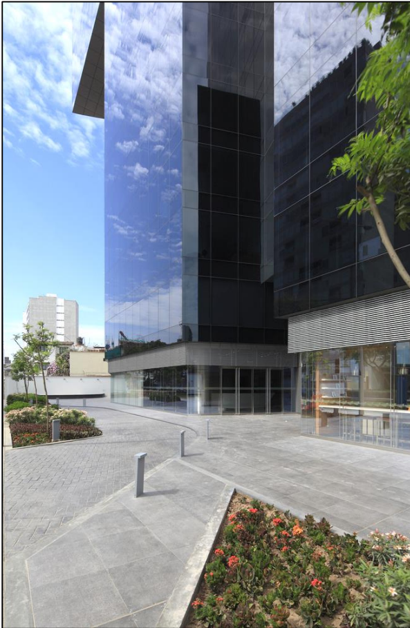
Imagen 16 - Vista a nivel de peatón del hall de ingreso, http://www.pragmaarquitectos.com.pe/prisma-business-tower.html (Febrero 2018).
