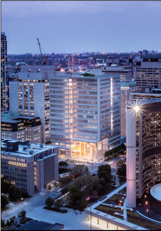
Imagen 8 - Vista Aérea de la Nueva Corte de Toronto, recuperado de http://www.rpbw.com/project/new-toronto-courthouse (2017).
