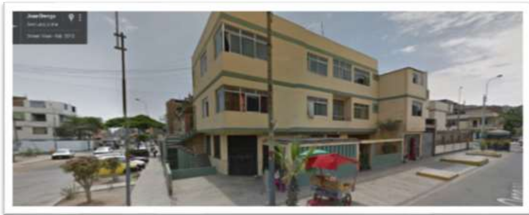
Fig. N° 8 Edificio Administrativo Central Fuente: Google Maps – Elaboración: Google Maps
