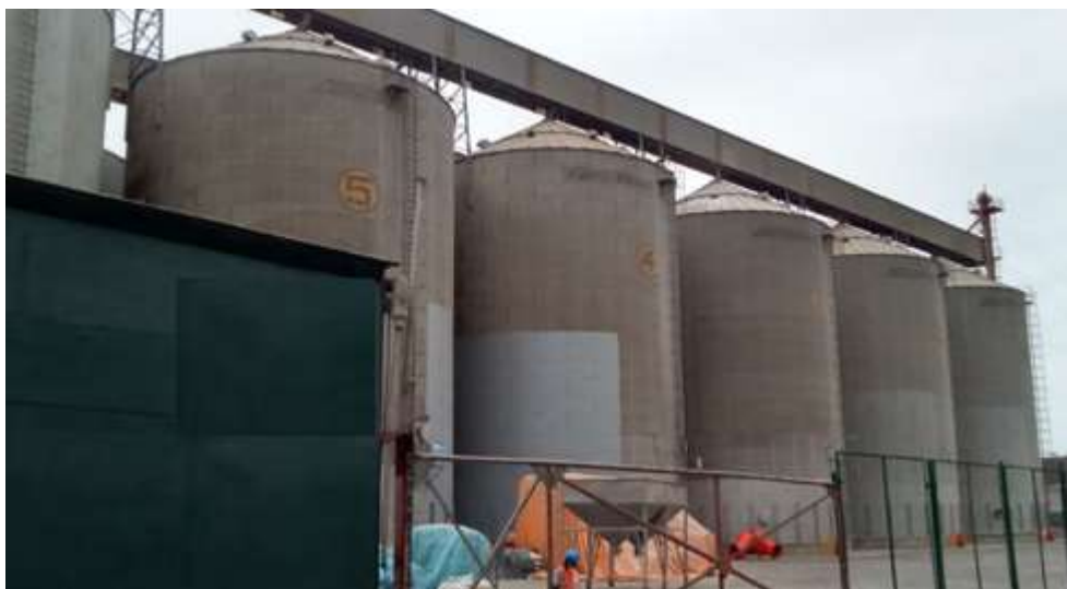
Figura 4. Almacenes en silos metálicos. Fuente: Almacén a granel.
