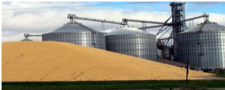
Figura 13. Almacén en losas a la intemperie
