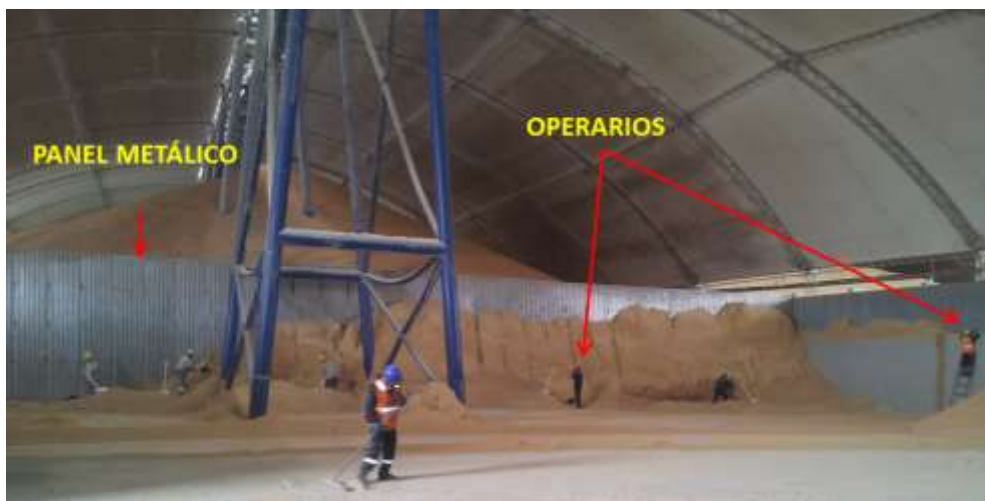
Figura 3. Liberación de paneles metálicos en bajo techo. Fuente: Almacén a granel.
