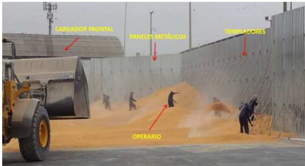
Figura 2. Liberación de paneles metálicos en losas a la intemperie. Fuente: Almacén a granel.
