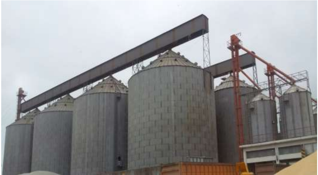
Figura 24. Almacén silos metálicos
