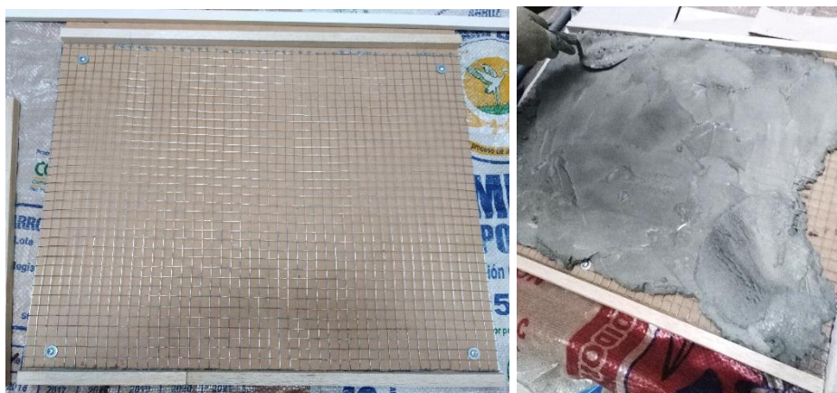
Figura 30. Tarrajeo de paneles de 1.5 cm de espesor
