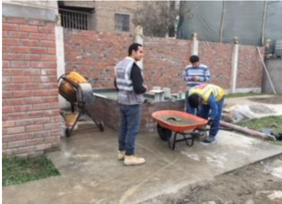
Figura 5: Proceso de mezclado del concreto
