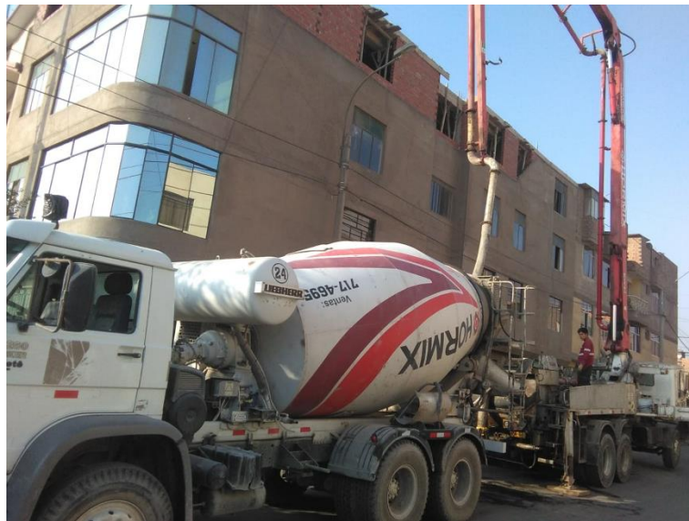
Figura 1: Vaciado por bombeo de concreto premezclado
