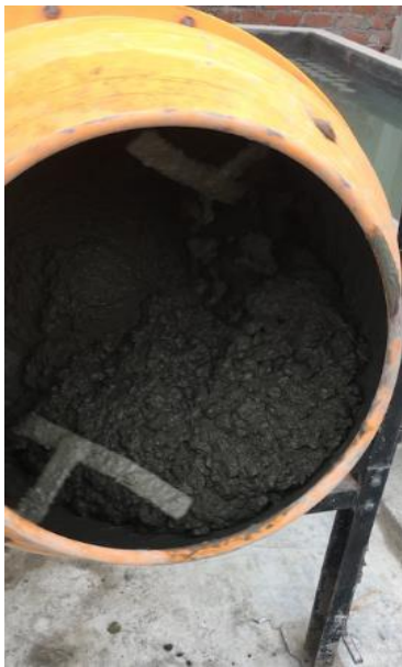
Figura 6: Mezcla de concreto
