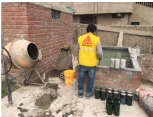
Figura 7: Elaboración de probetas de concreto
