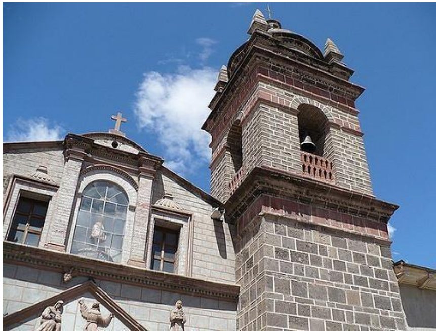
Imagen 15. Campanario de la Iglesia San Francisco. Elaboración propia
