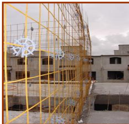
Figura N° 4: Aplicación de Separadores en Obra
