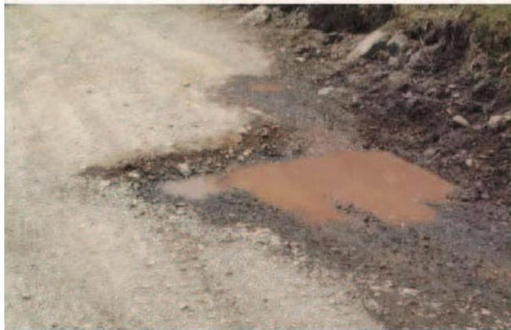
Figura N° 7 Gravedad 1: Pueden ser reparadas por mantenimiento rutinario
