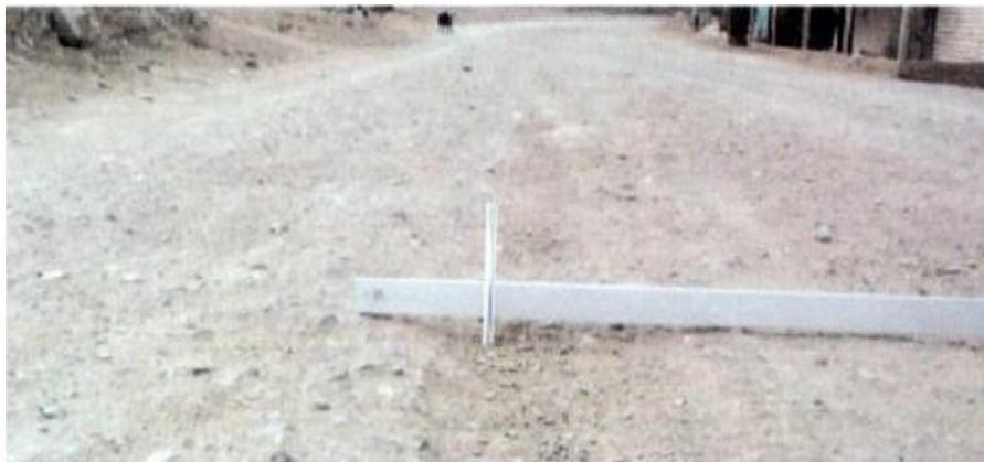
Figura N° 1 Gravedad 1: Huellas /Hundimiento sensibles al uso pero  $< 5$  cm y 10 cm
