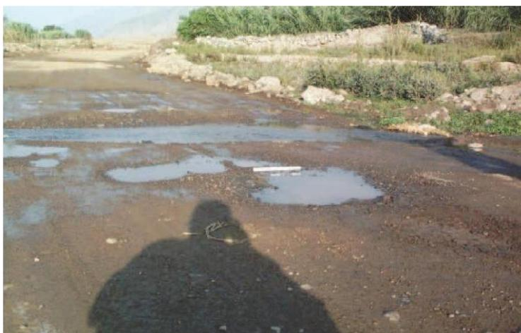
Figura N° 9 Gravedad 3: Necesita una reconstrucción
