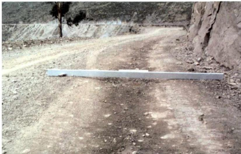
Figura N° 3 Gravedad 3: Huellas /Hundimientos >10 cm
