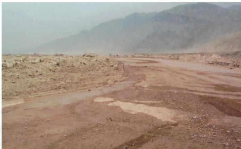
Figura N° 8 Gravedad 2: Necesita una capa de material adicional
