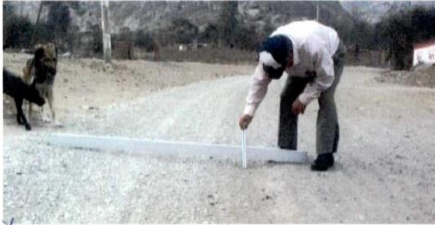
Figura N° 2 Gravedad 2: Huellas /Hundimientos entre 5 cm y 10 cm
