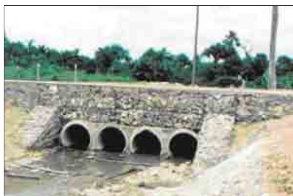
Figura N° 36: Alcantarilla de sección circular multiceldas Fuente: http://www.ingenierocivilinfo.com/2011/03/alcantarillas-circulares-o-tubos-de.html
