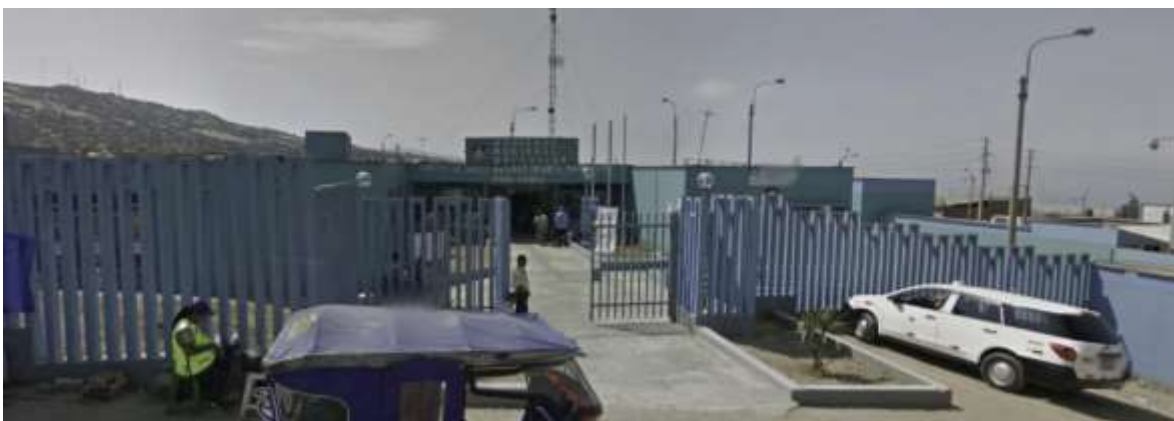
Figura 24. Vista del Centro de Salud Materno Infantil Pachacutec Perú-Corea desde la avenida Los Cedros.
