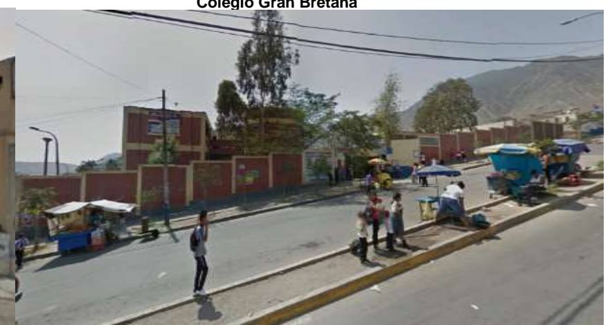
Figura 103. Colegio Gran Bretaña ubicado en la Av. Coricancha.
