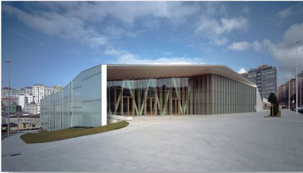
Imagen 6. Vista de ingreso principal del CENTRO SOCIO CULTURAL ÁGORA. Fuente Sitio web: https://www.archdaily.pe/pe/02-141024/centro-socio-cultural-agora-rojofernandez-shaw-liliana-obal (abril 2018).
