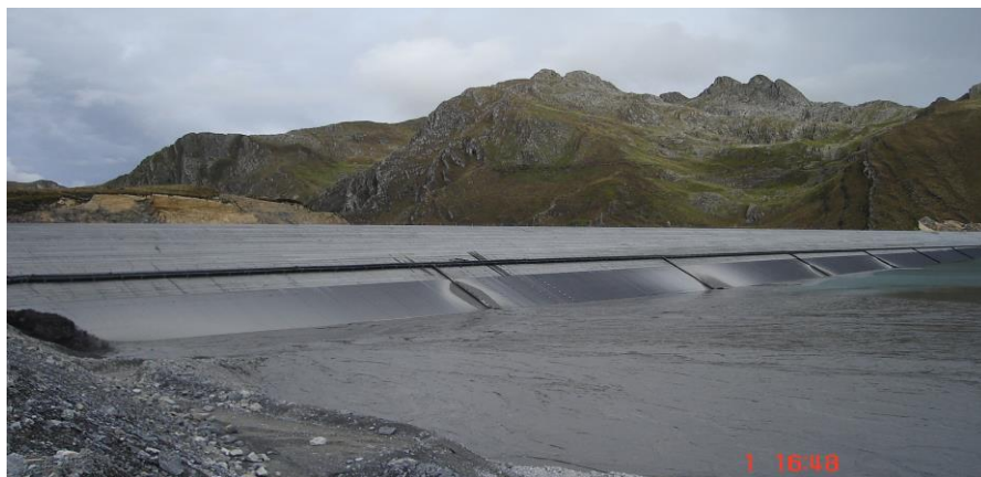
Foto11: Presa de Relaves
