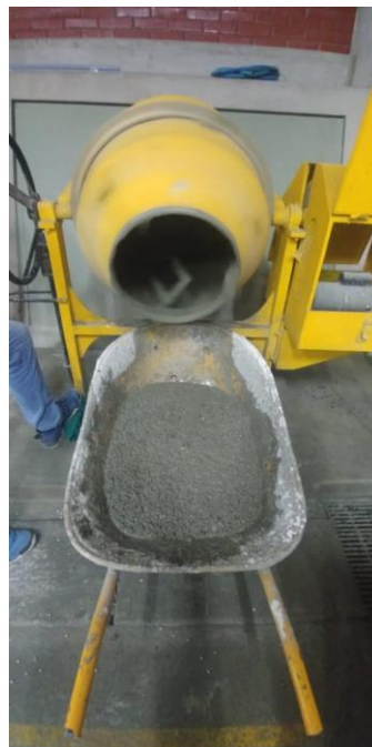
Figura 13: Mezcla de concreto.
