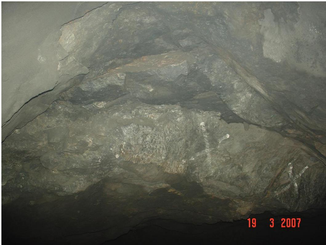
Fotografía 1. Se puede apreciar la roca suelta sostenida por la irregularidad de MR
