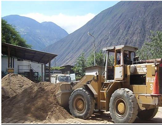
**Paso 1: Se mezcla la arena para uniformizar la humedad en la misma; luego se procede con la toma de muestra para el porcentaje de humedad.**
