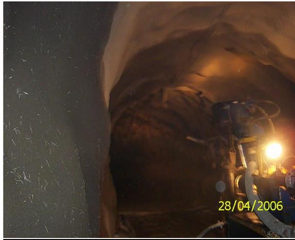
**Paso 8: Verificamos que la superficie este con el espesor adecuado y uniforme.**
