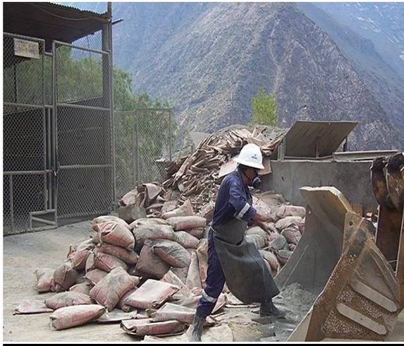
**Paso 3: Se carga la pala con el cemento, y se procede a cargar la tolva pesadora con el mismo.**
