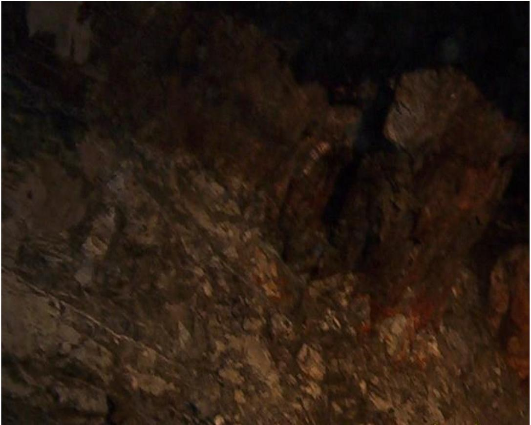
Fotografía 3. Se puede observar la roca desprendida del MR, con la fisura paralela a la sección del astial.
