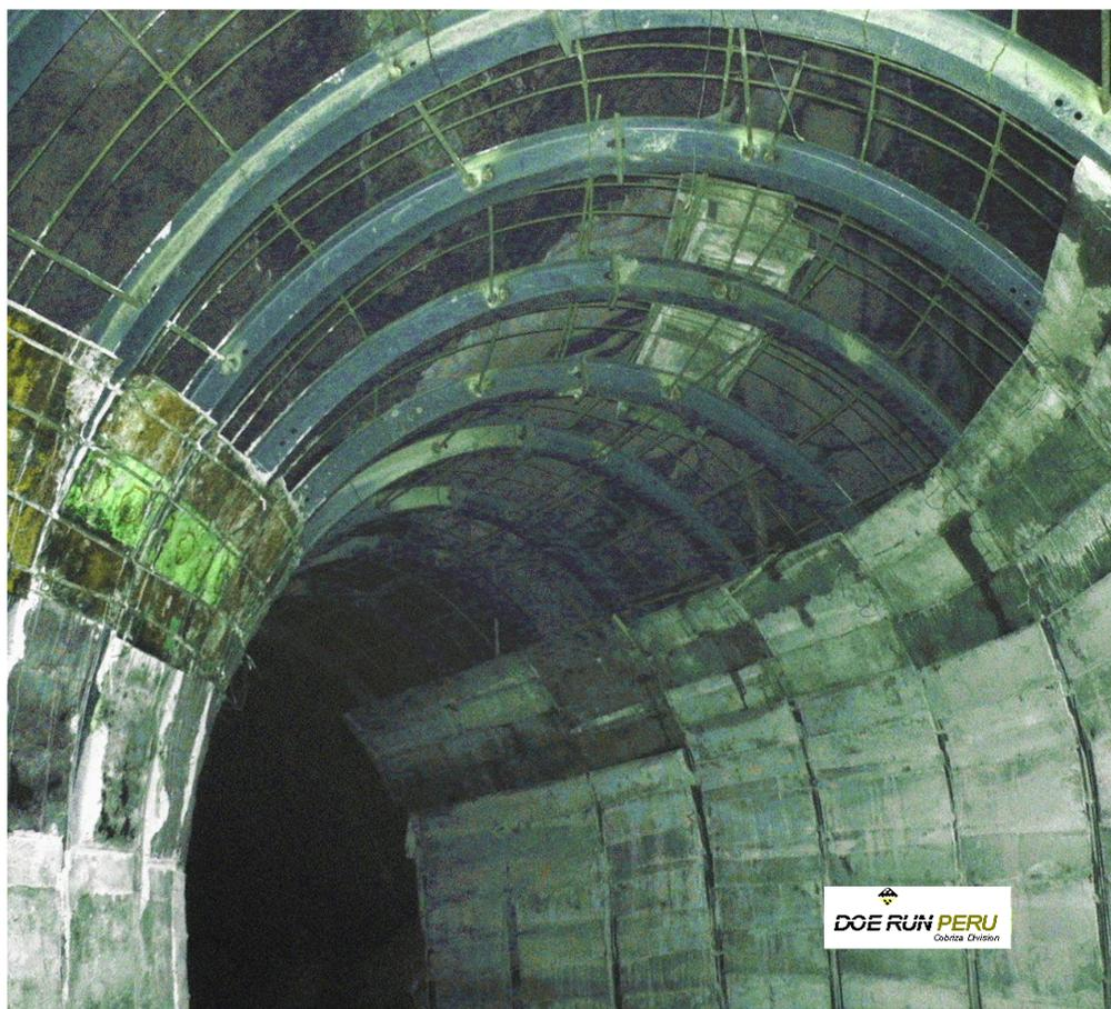
Fotografía 5. Se observa el armado de la cimbra de 5.5 metros de altura con una sección de 8 mts.
