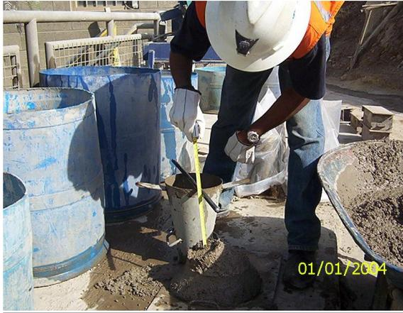
**Paso 15: Se comprueba que el slump del concreto cumple con el requerido.**
