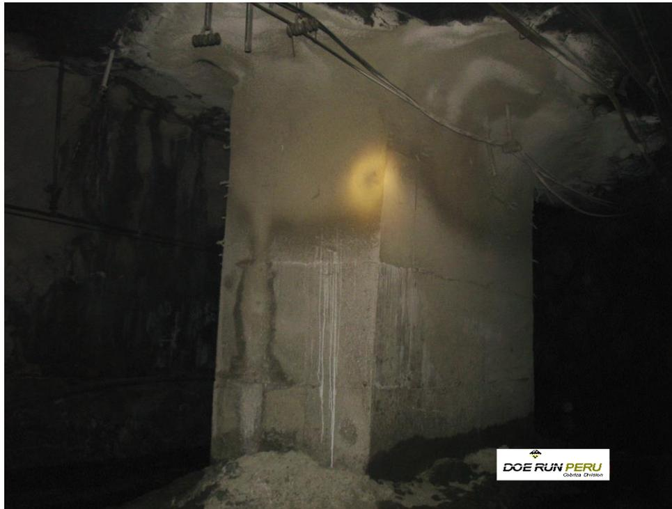
Fotografía 4. Se observa un muro de concreto armado, el cual sostiene el MR
