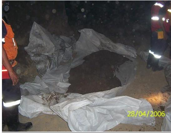
**Paso 6: Una vez terminado de lanzar el shotcrete se recopila el material de rebote.**
