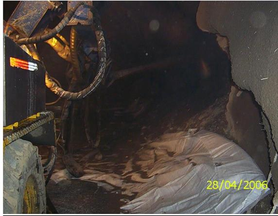
**Paso 4: procedemos a lanzar el concreto sobre la segunda sección.**
