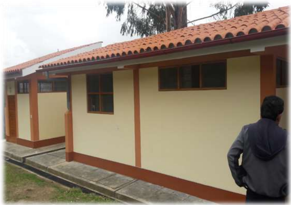
Foto 7 Vista frontal de la edificación tipo cocina y servicios higiénicos en la IEI N°264
