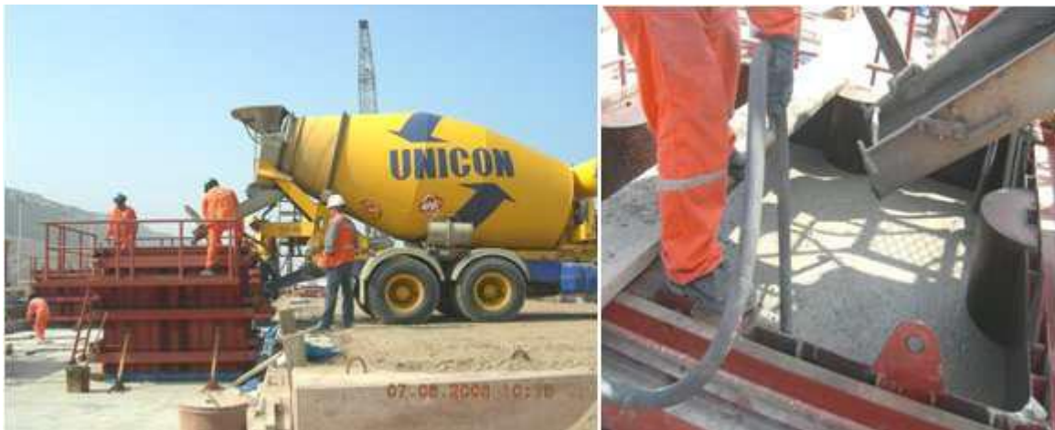
IMAGEN 3.8. Secuencia de vaciado de un BCR. En tres capas del mismo volumen, vibrando cada una.
