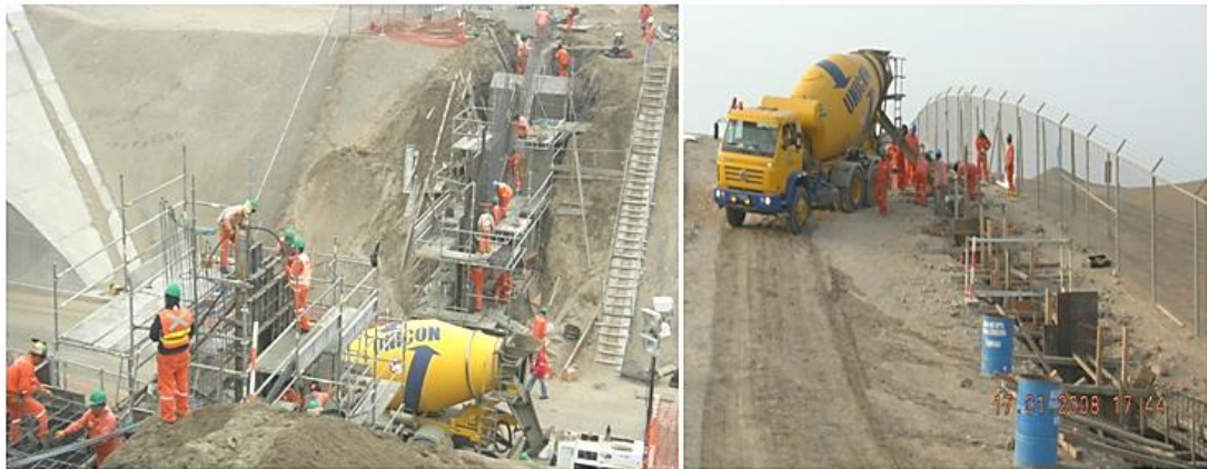
IMAGEN 4.2. Vaciado en el Cerco Perimétrico.
