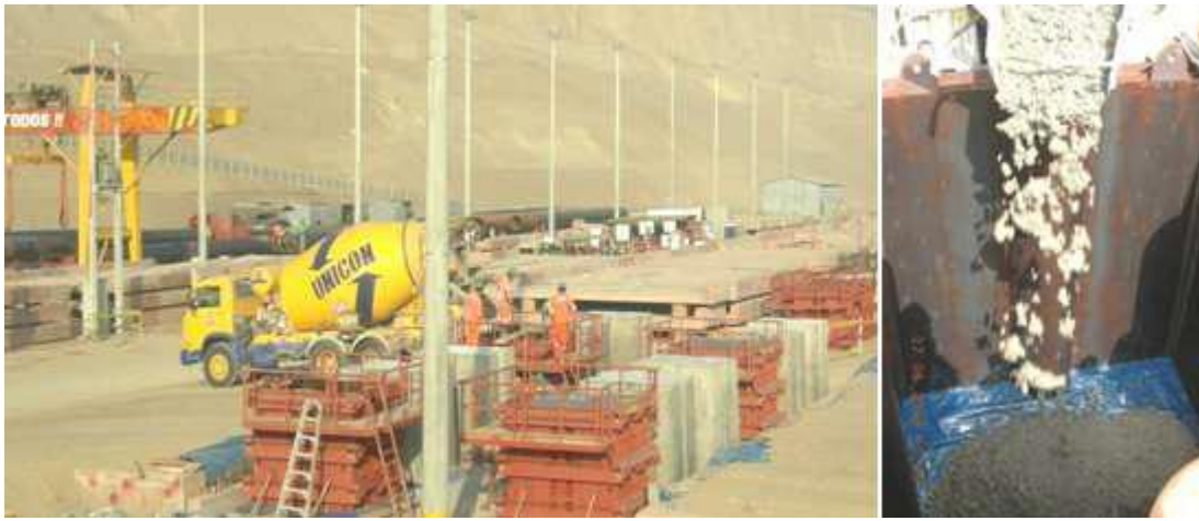
IMAGEN 3.9. Vaciado de los BCR en la zona de producción.
