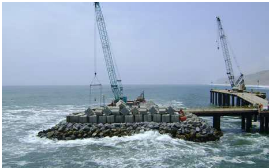
IMAGEN 3.6. Colocación de estructuras BCR, en el muelle secundario.
