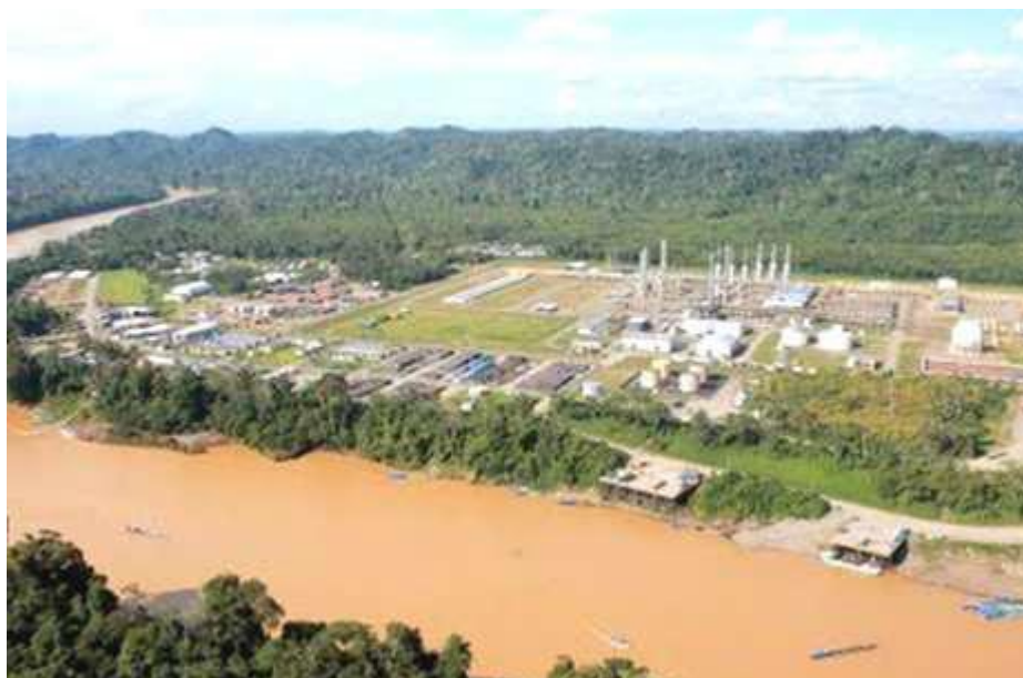
IMAGEN 1.1. Planta de extracción de gas: Las Malvinas Cuzco-Perú.
