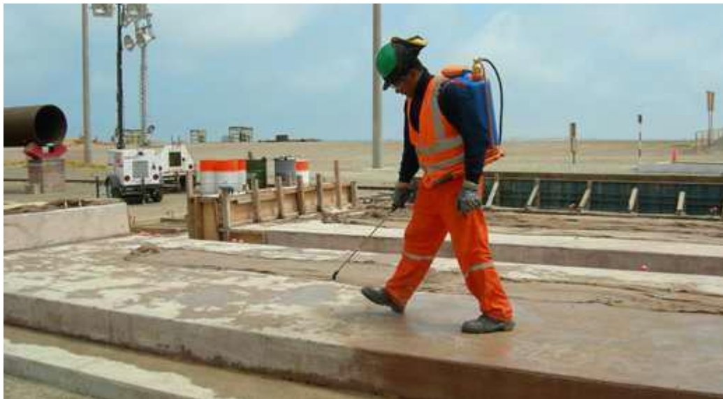
IMAGEN 3.4. Curado de las losas pre-fabricadas.
