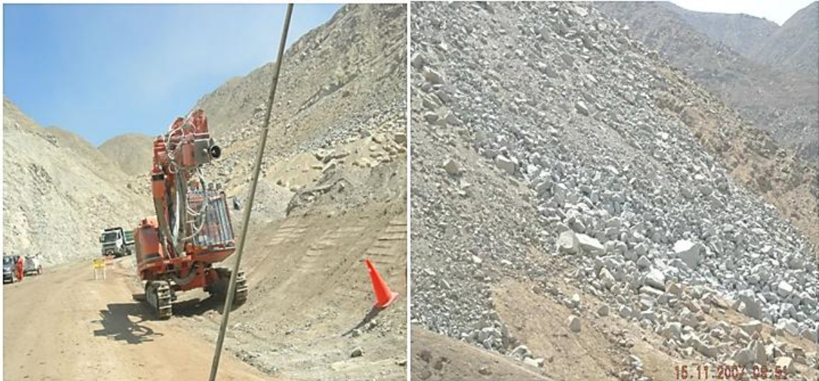
IMAGEN 4.1. Cantera Culebrillas – CDB, perforadora de cdb y del área de extracción - lugar cantera culebrillas km 26.
