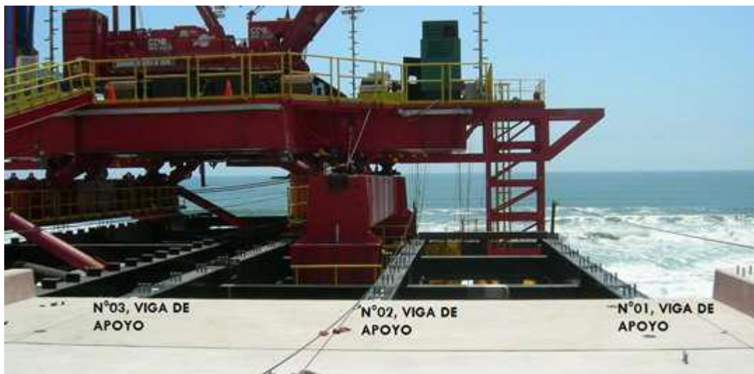
IMAGEN 3.3. Las tres vigas de apoyo y en ellas los pernos de anclaje, que irán dentro del espacio dejado por las cajas en las losas.
