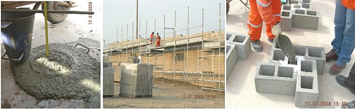
IMAGEN 4.3. Ensayo de slump, Asentado de Bloquetas y Muestreo de Testigos (a pie de obra tomado por CDB).
