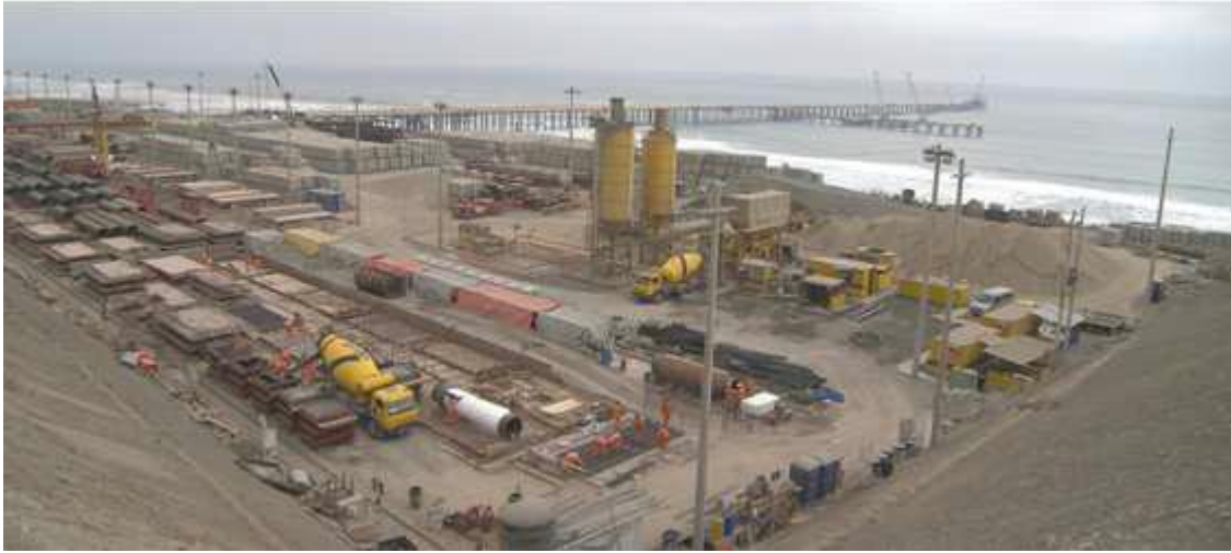
IMAGEN 3.1. Vista general de la zona de producción de pre-fabricados (Losas y BCR).
