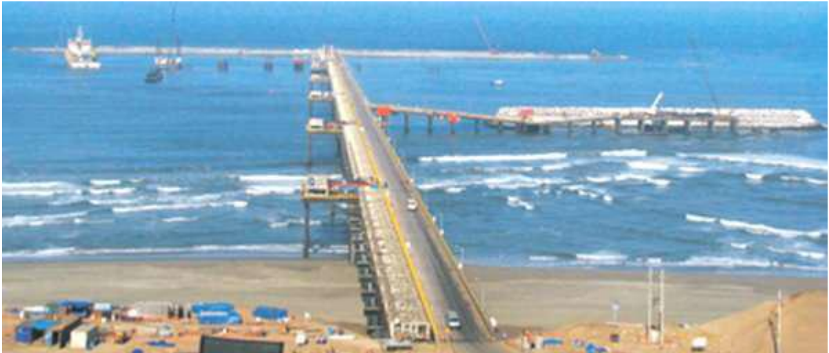
IMAGEN 1.7. Muelles Principal y secundario (perpendicular), además del rompeolas principal y secundario respectivamente.
