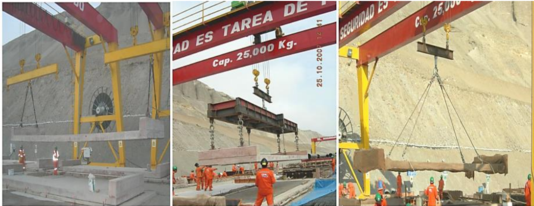
IMAGEN 4.6. Problema y Soluciones del transporte de Losas.
