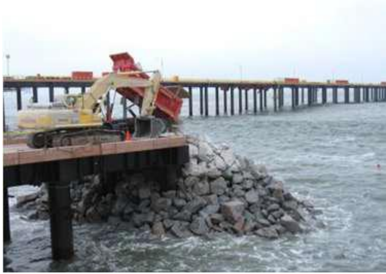
IMAGEN 1.8. Descarga de roca, para el relleno del rompeolas secundario.
