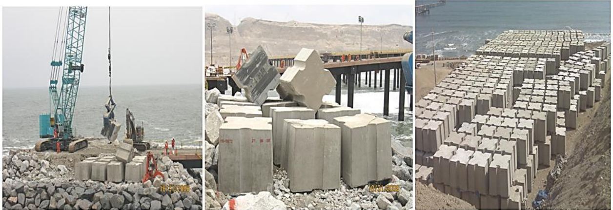
IMAGEN 4.8. Inicio de Colocación en el RLOF.
