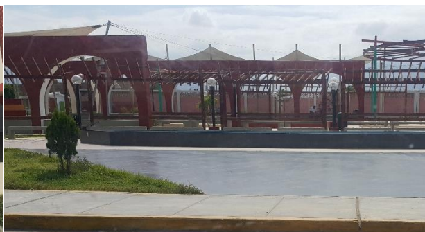
Figura N°41-Plazuela del colegio D.M Ruiz FUENTE: Autoría propia
