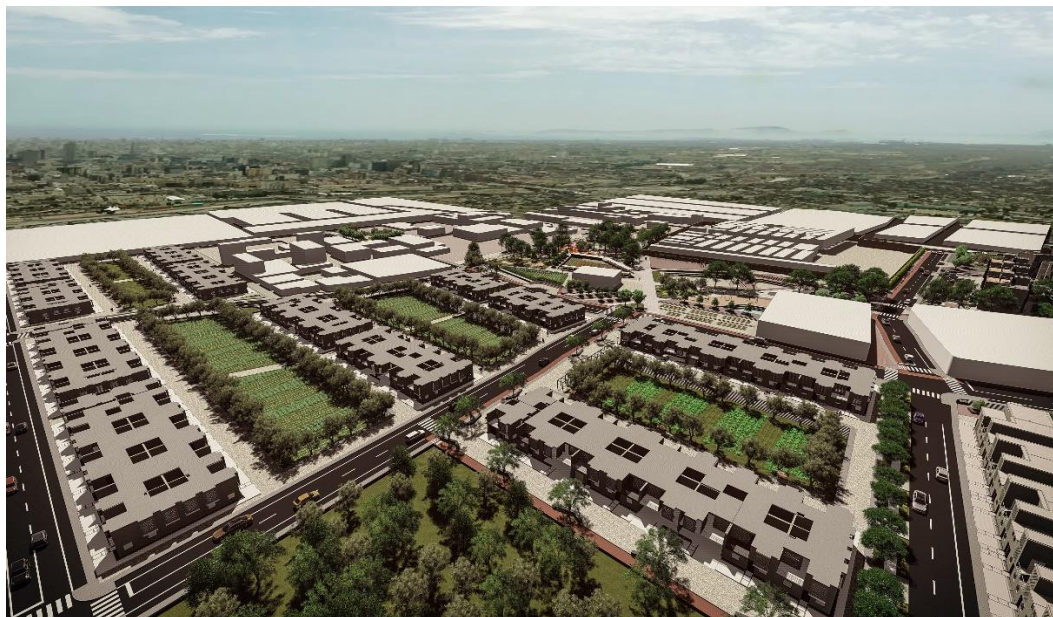
IMAGEN N° 212: Vista Aérea de Proyecto FUENTE: Elaboración Propia/ 06-03-2018
