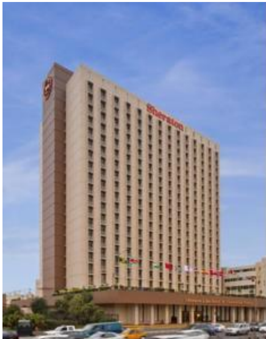
Vista del Hotel Sheraton de Lima
