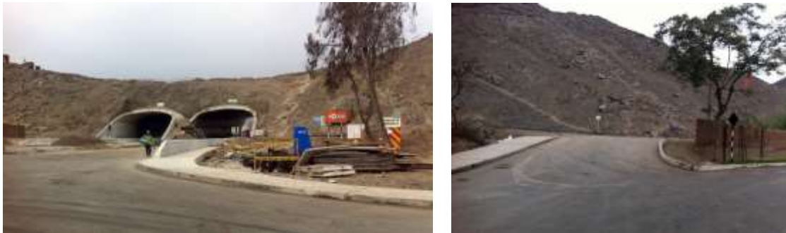
Figura 28. Izquierda. Obras de la ampliación de la Av. Javier Prado
