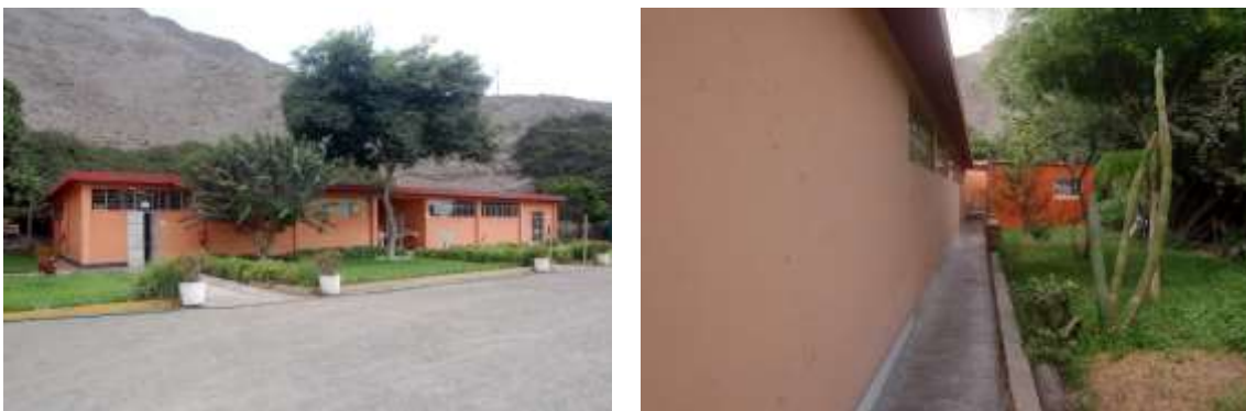
Figura 71. Vistas del Pabellón 3 o Depósitos
