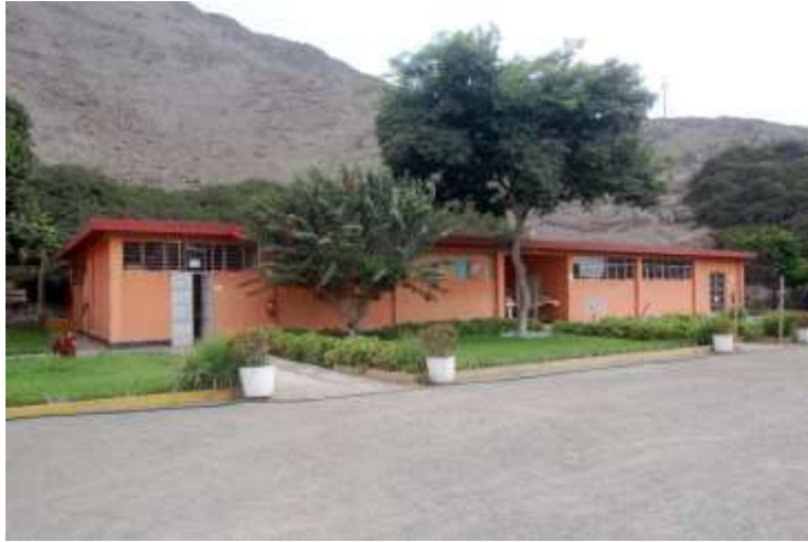
Figura 64. Vista frontal del Pabellón 3 o Depósitos
