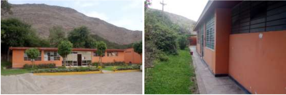
Figura 59. Pabellón 1 o Administrativo
