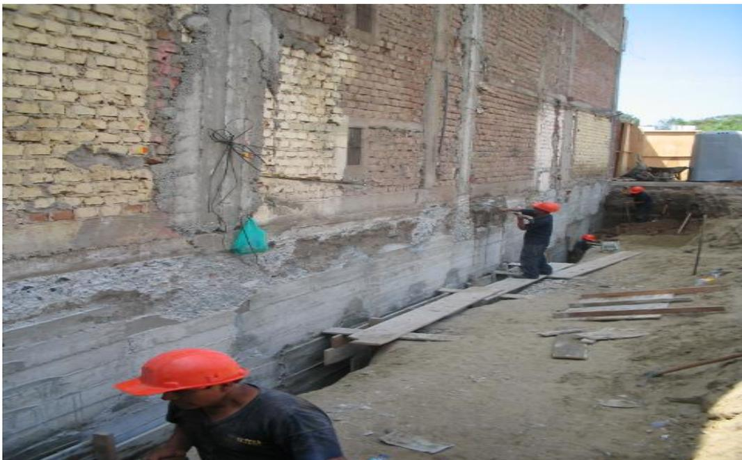
Vista de la calzadura realizada en el edificio de tres pisos
