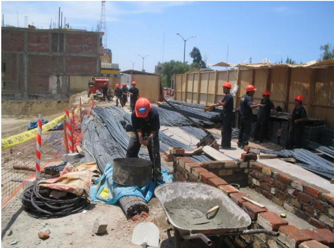
En esta toma se aprecia parte del acero y del personal que realiza el corte y armado del acero de las zapatas
