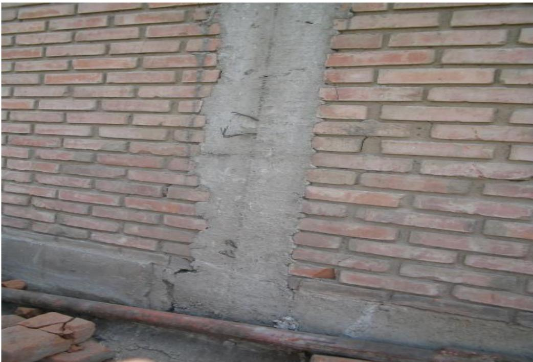
Vista de la columna del mismo cerco se aprecia que esta columna ha sido insertada después de haber construido el muro
