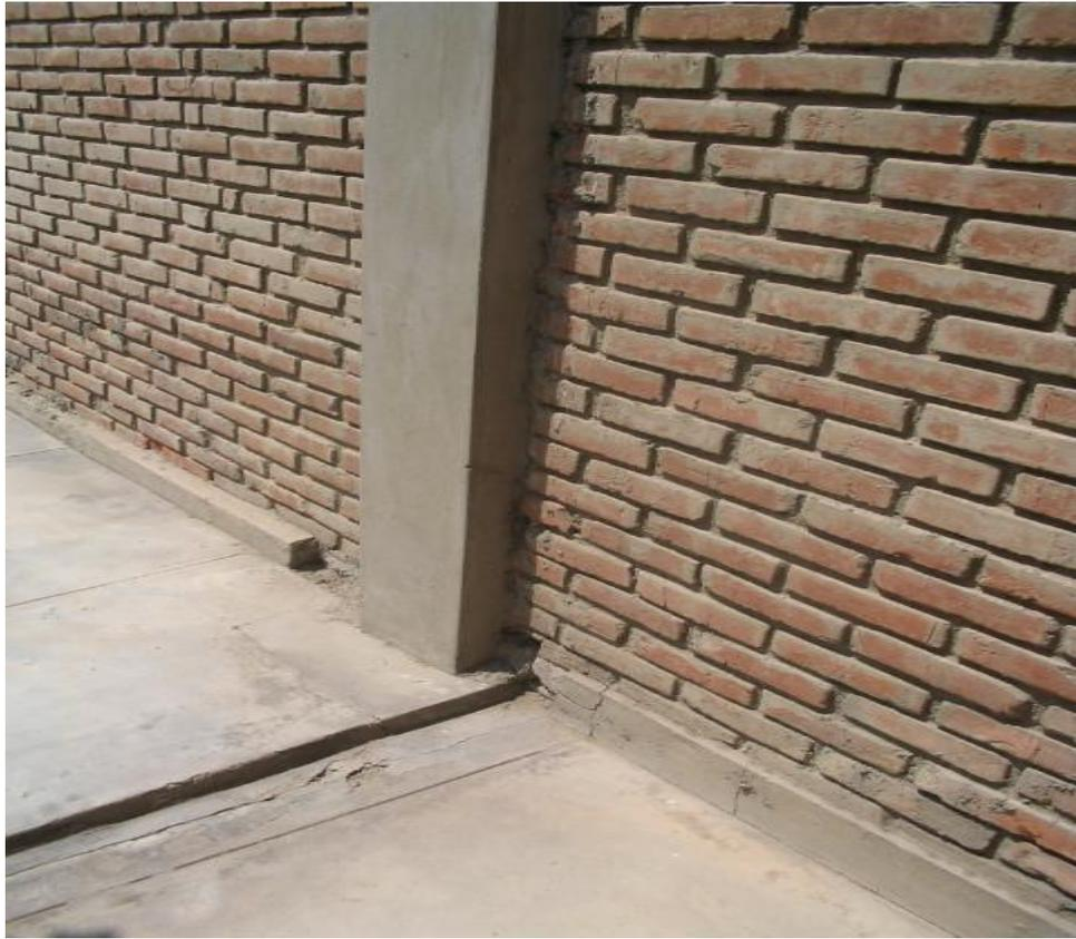
Vista del Muro y la columna desde el interior de la casa de reposo se aprecia en la vereda el ancho de la zapata
