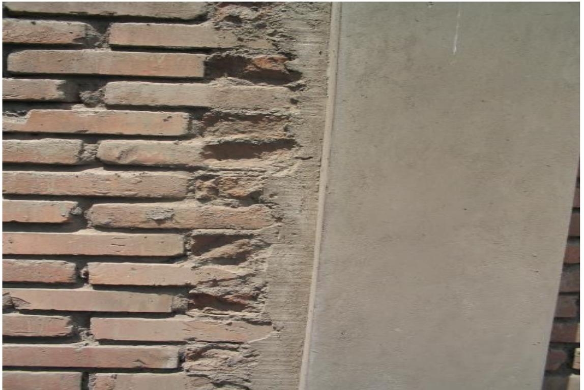
En vista se aprecia que las mochetas del muro han sido picadas y reemplazadas por columnas
