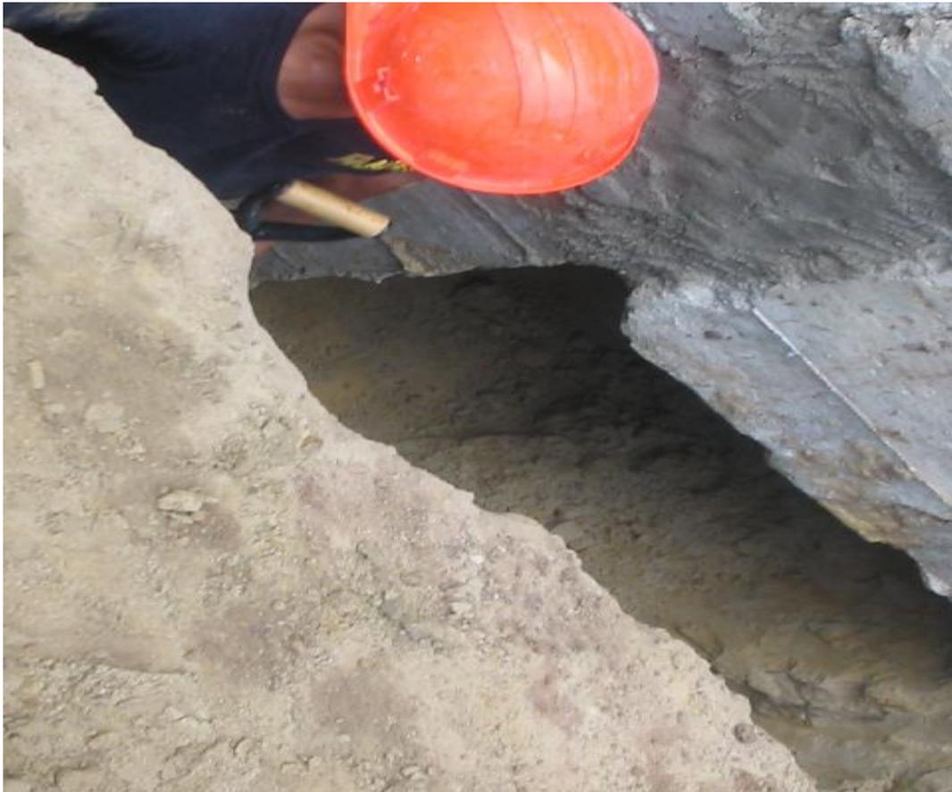
En esta toma se aprecia la excavación realizada para la calzadura del edificio de tres pisos que colinda con el terreno.
