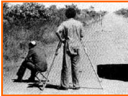
Fig. 34 Método de la Mira y Nivel
