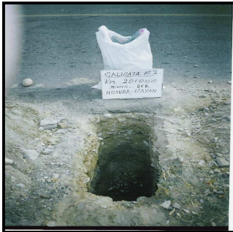
Fig. 46: Ensayos Destructivos (calicata)
