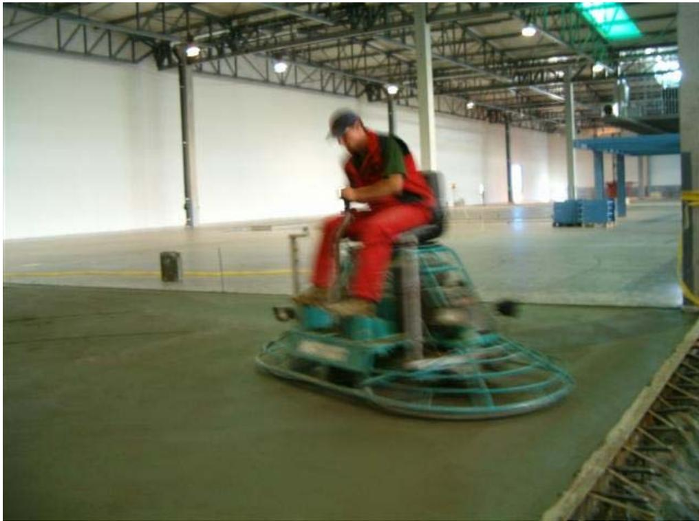
*Vibrado piso con concreto reforzado con fibra de acero*
