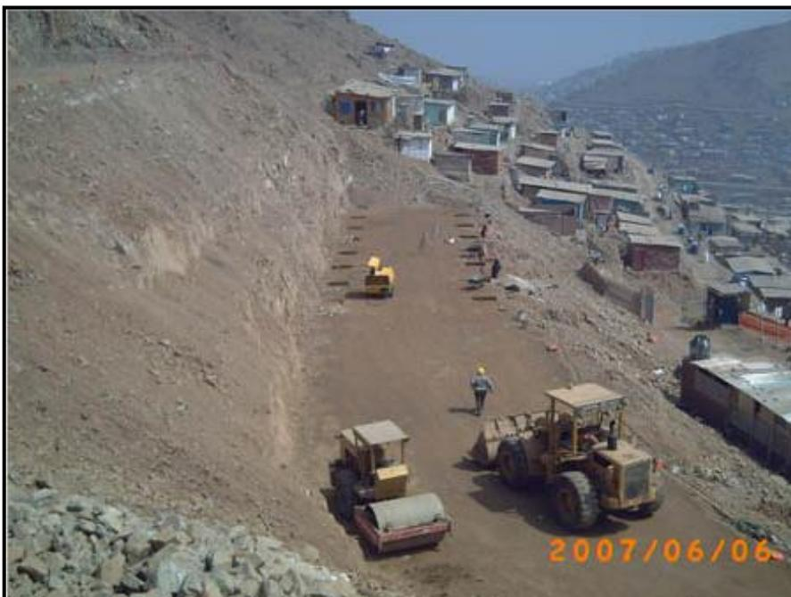
**Foto N°33:** Inicio de tren de actividades, excavación de la zapatas.
