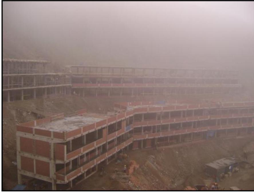
**Foto N°40:** Tren de vaciados en losas aligeradas, inicio de la albañilería.
