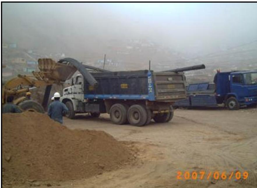
**Foto N°15:** Transbordo de materiales, ayudado por el cargador frontal. Depósito de agregados.
