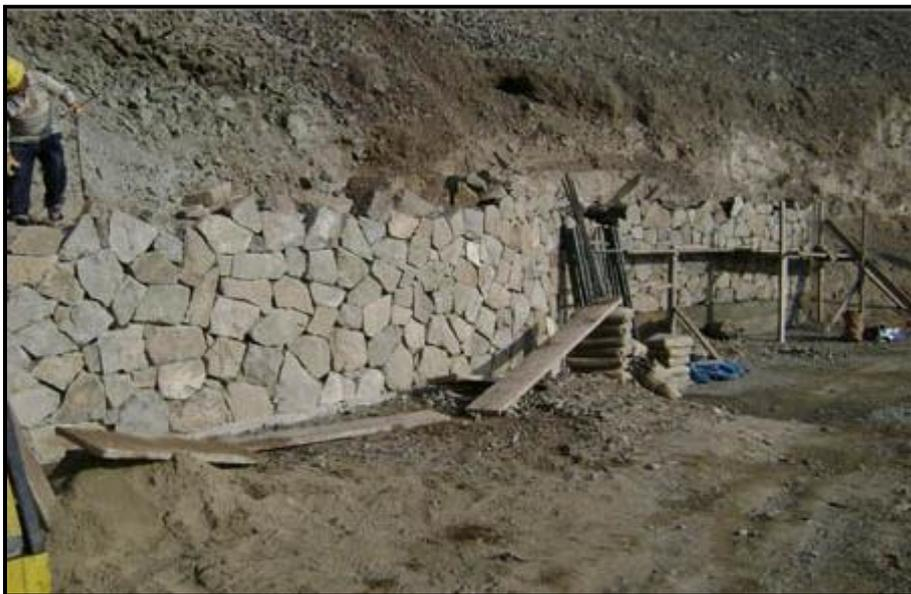
**Foto N°27:** Proceso constructivo del muro de contención.
