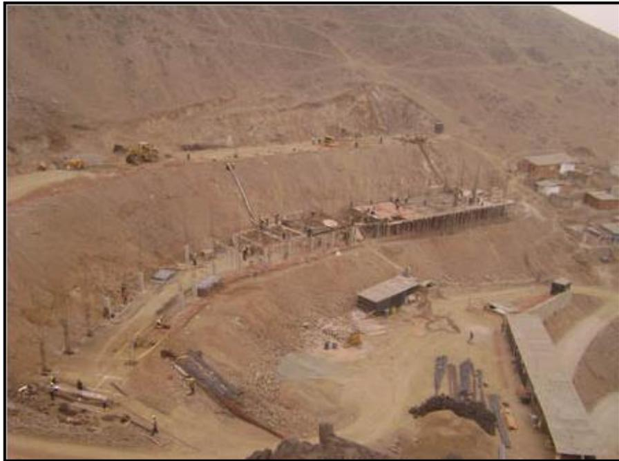
**Foto N°36:** Inicio de vaciados de losa aligerada, se planteo vaciar desde la parte superior, evitando el acarreo.
