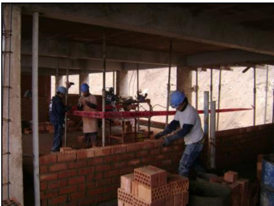
**Foto N°43:** Proceso de albañilería, se utilizó el método escaniplo para lograr rendimientos altos.
