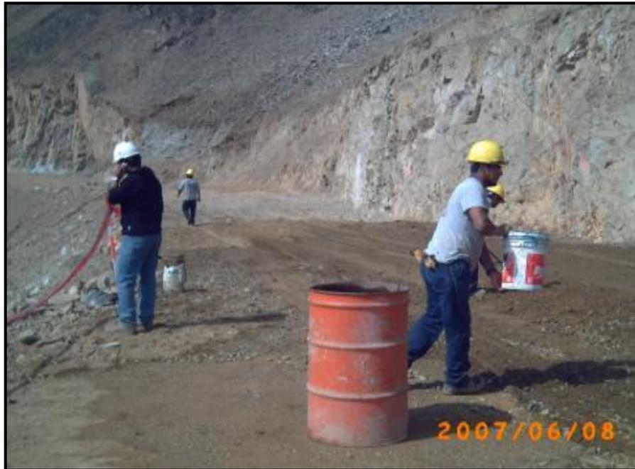
**Foto N°30:** Preparación de la sub rasante, mejoramiento y nivelación.
