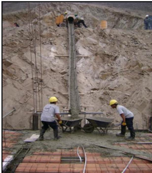
**Foto N°37:** Se construyeron chutes metálicos para los vaciados de losas.
