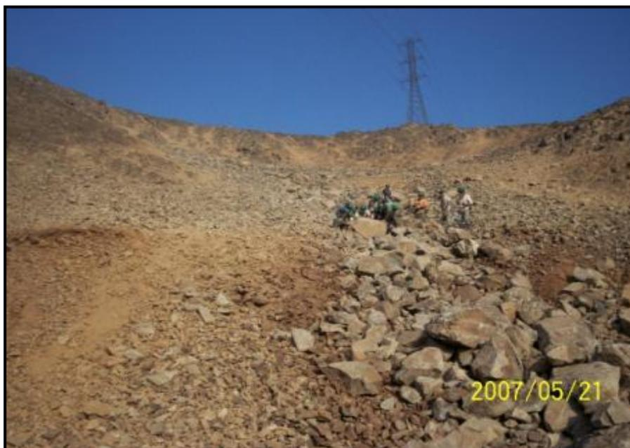
**Foto N°13:** Vista etapa de desquinchado de quebrada, todo el material suelto se llevo a limpiar.
