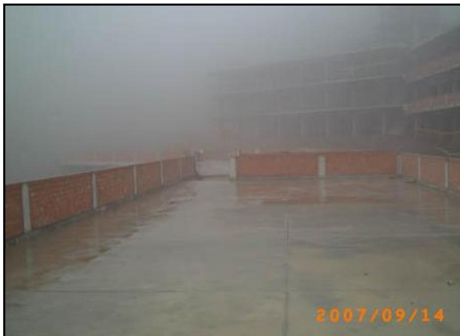
**Foto N°19:** La humedad no permitía el vaciado de concreto, en algunos sectores.
