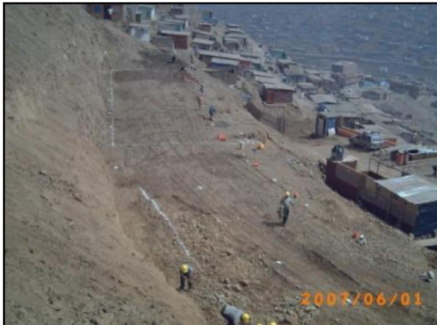
**Foto N°31 :** Trazado y nivelación de las plataforma.
