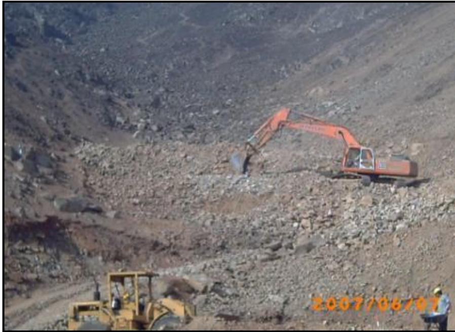
**Foto N°24:** Conformación de terraplanes en quebrada, con material del desquinchado. Se ahorra la eliminación de materia producto del desquinchado.
