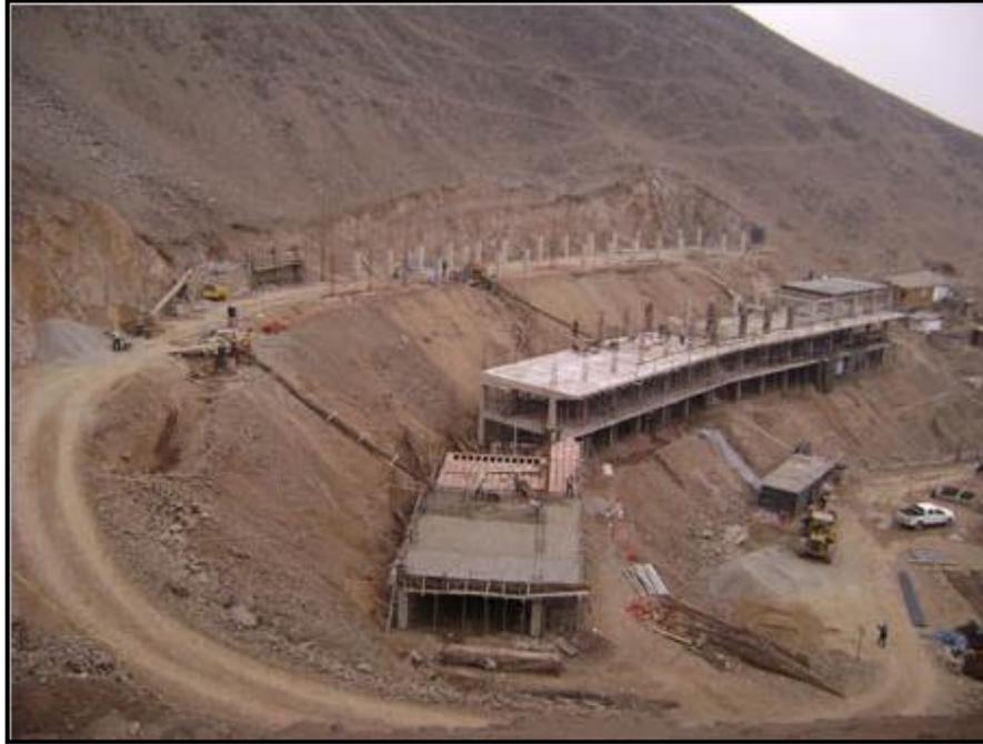
**Foto N°38:** Tren de vaciados en losas aligeradas.
