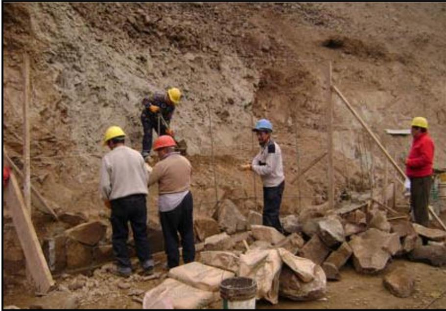
**Foto N°26:** Inicio de construcción del muro de contención con material propio, excedente del desquinchado.
