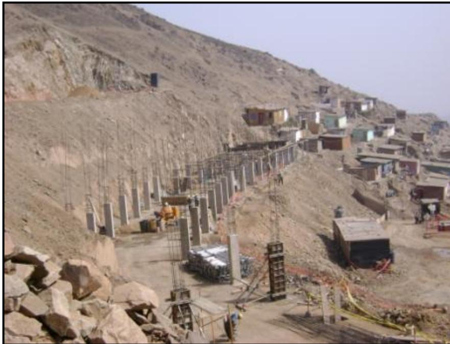
**Foto N°34:** Tren de columnas y zapatas.
