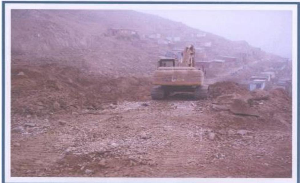
**FOTO N°3:** Vista panorámica donde se observa la plataforma número dos en proceso de nivelación.
