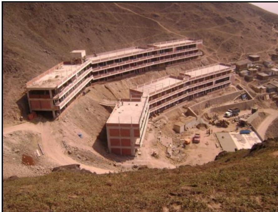
**Foto N°41:** Termino de obras de concreto y la albañilería en proceso.
