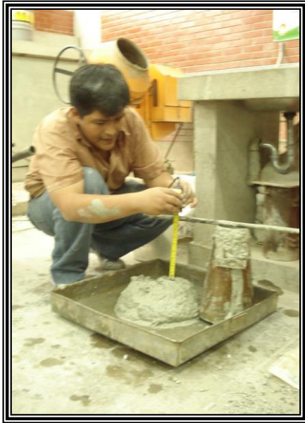
REALIZACIÓN DE MEZCLA DE PRUEBA Y CONTROL DE SLUMP
