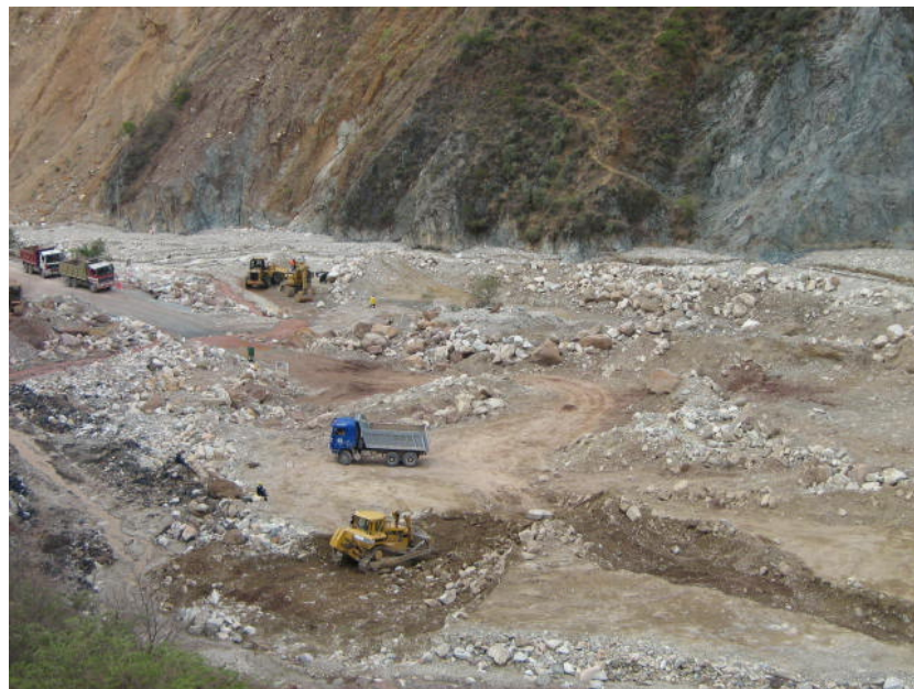
Foto 10 - Cantera Culebrillas: Vista de oeste a este (25/09/06).
