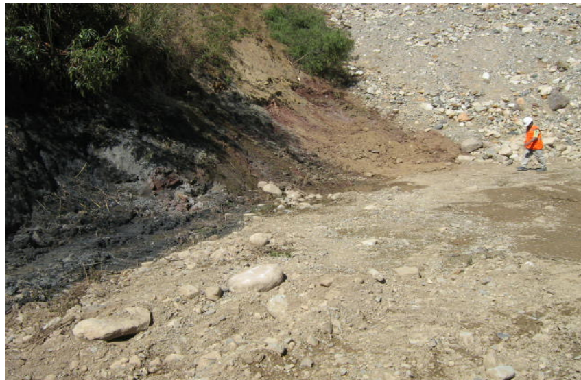
Foto 27: Presa Alpamarca – Limpieza del talud sobre el estribo derecho de la presa. Véase los afloramientos de agua 814/09/06).
