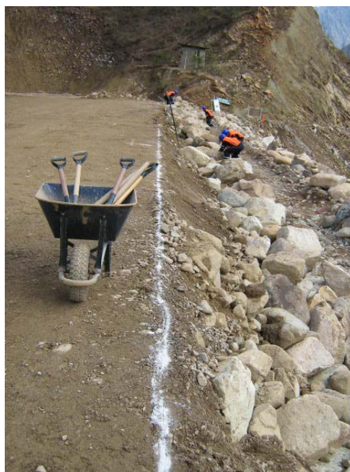
Foto 35: Presa Alpamarca – Demarcación con tiza del hombro de la capa de relleno de grava N° 2 para el perfilado del talud aguas abajo y conformación del rip rap (19/09/06).
