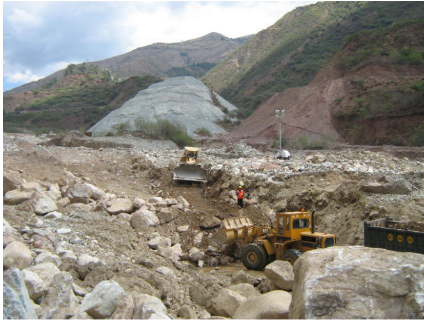
Foto 18 - Cantera Culebrillas-Chilcapampa: Operación de carguio.
