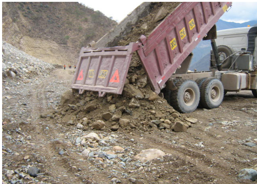
Foto 29: Presa Alpamarca - Inicio de los rellenos de grava en la presa (13/09/06).
