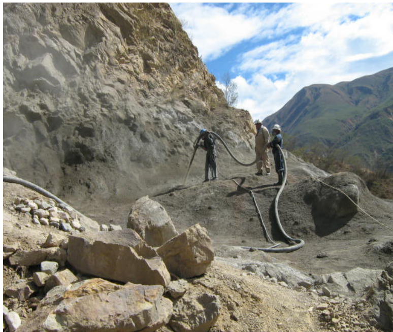
FOTO 49: TRABAJOS DE CONCRETO LANZADO SOBRE EL ESTRIBO IZQUIERDO (SHOTCRETE, 30/09/06).
