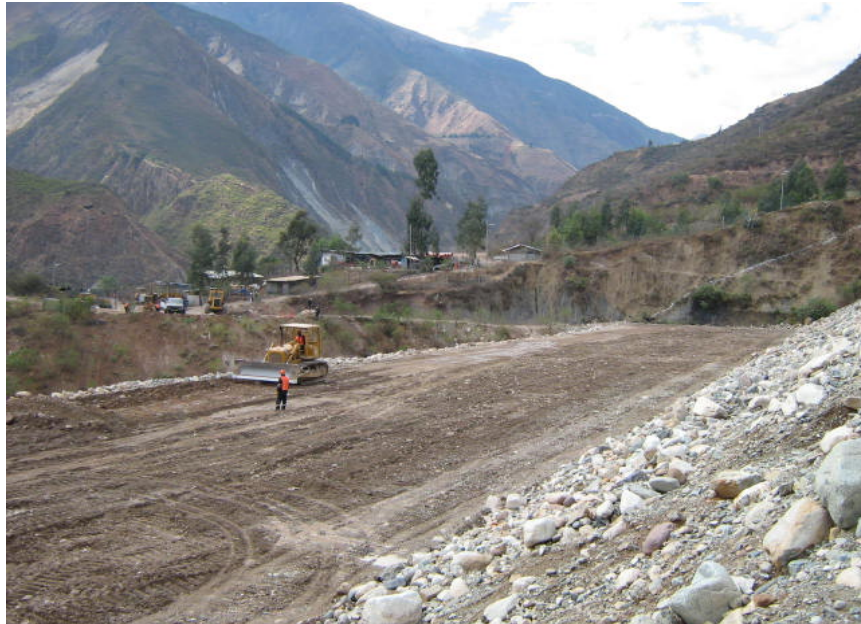
Foto 26: Presa Alpamarca – Escarificado de la subrasante del relleno existente en la cota 2292.25 msnm para empalmar con los rellenos de grava a efectuarse (12/09/06).
