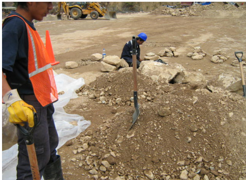
Foto 45: Presa Alpamarca – Determinación de la granulometría encontrada sobre la calicata que sirvió para el calculo de densidad in situ en el relleno de grava (27/09/06).
