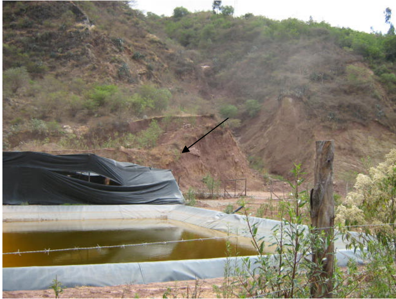
Foto 16 - Cantera Tunaspampa: Material para suelo de baja permeabilidad (13/09/06).
