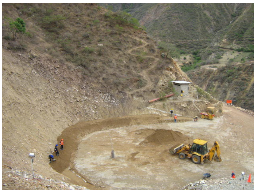
Foto 43: Presa Alpamarca – Conformación de la quinta capa de filtro (25/09/06).
