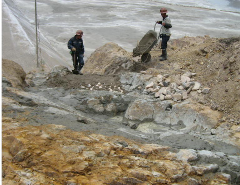
FOTO 48: VACIADO DE CONCRETO DENTAL SOBRE EL ESTRIBO IZQUIERDO (21/09/06).
