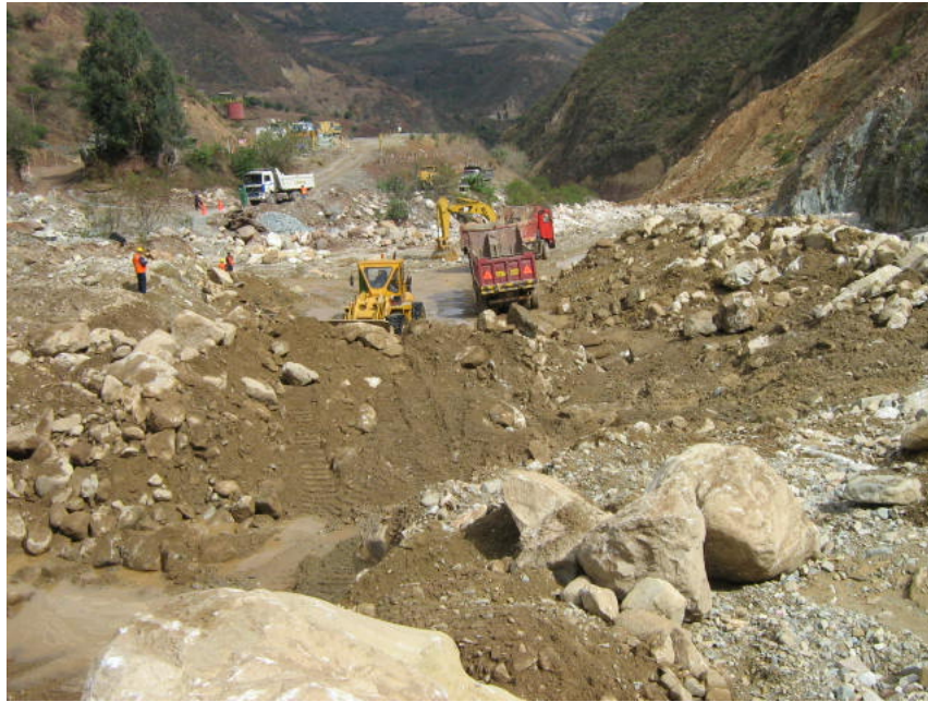
Foto 3 - Cantera Culebrillas: Vista de sur a norte - punto de carguío (19/09/06)
