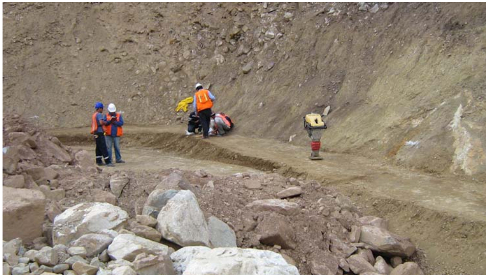
Foto 38: Presa Alpamarca – Ensayo de densidad in situ sobre la primera capa de filtro colocado sobre el estribo izquierdo (22/09/06).
