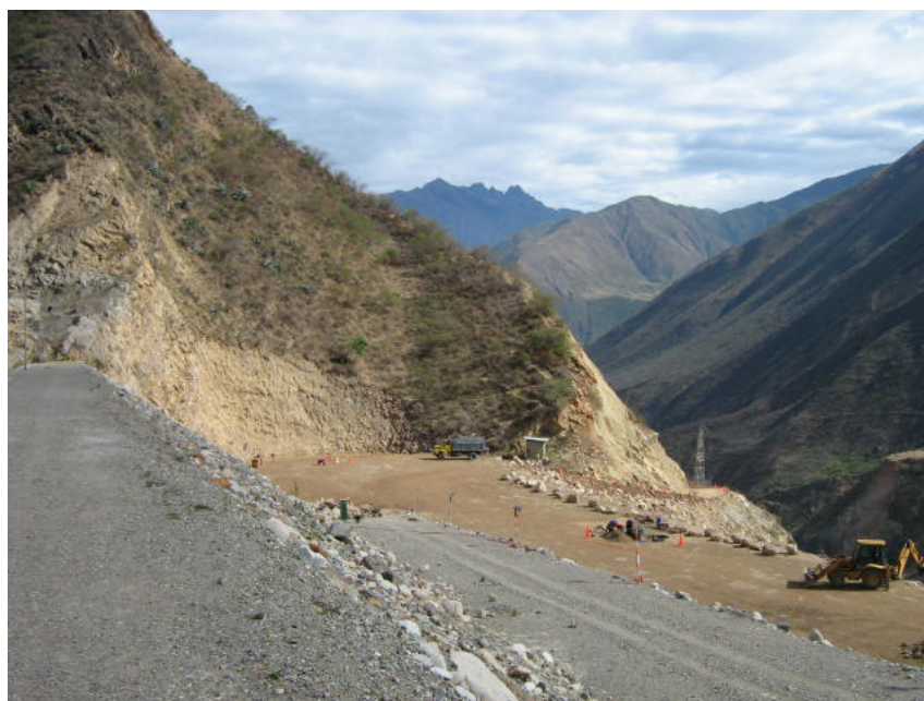
Foto 47: Presa Alpamarca - Otra vista de la conformación del relleno de grava (30/09/06).
