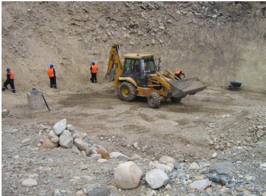
Foto 31: Presa Alpamarca – Limpieza del estribo izquierdo en donde se colocara el material de filtro (16/09/06).
