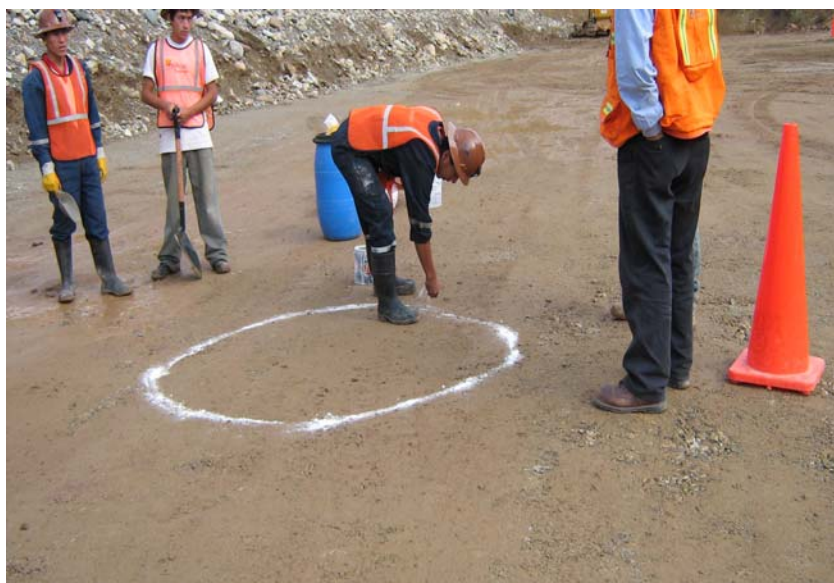
Foto 40: Presa Alpamarca – Marcado con tiza para la realización de calicata que servirá para controlar la densidad in situ de los rellenos de grava.
