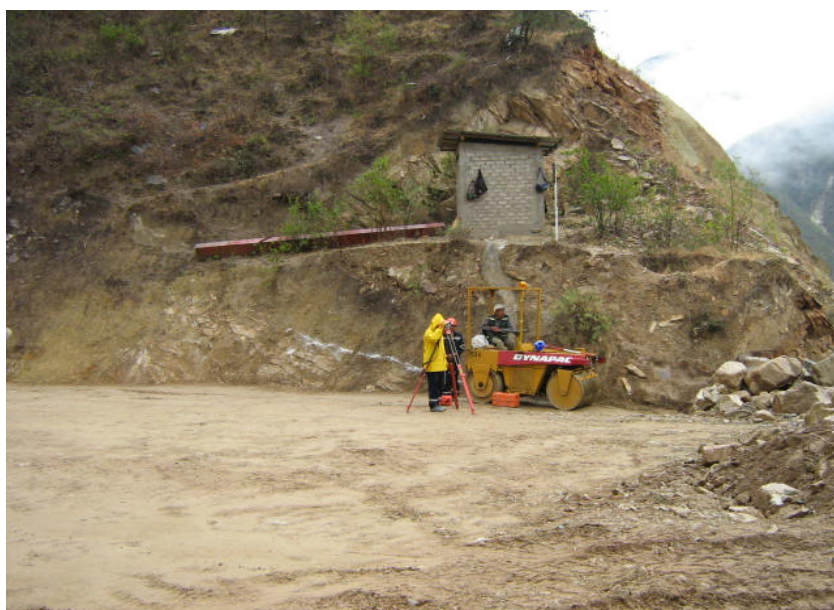
Foto 42: Presa Alpamarca – Compactación del material de filtro sobre el estribo izquierdo en su tercera capa (23/09/06).
