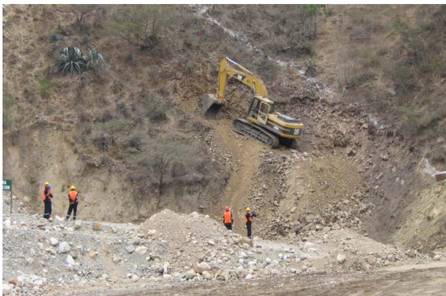
Foto 25: Presa Alpamarca – Inicio y desbroce del material inadecuado sobre el estribo izquierdo de la Presa Alpamarca (11/09/06).
