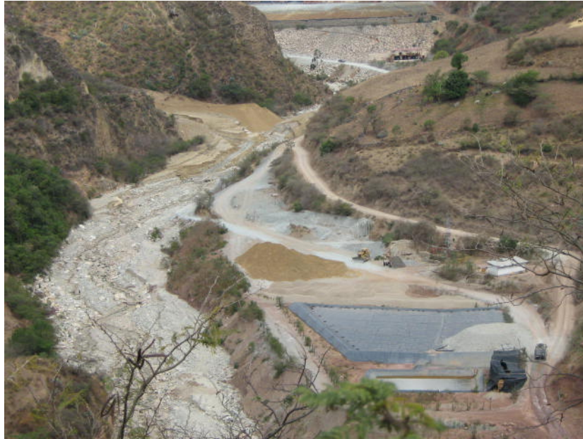
Foto 19: Vista de la Plataforma para el Almacenamiento de Filtro en Tunaspampa.
