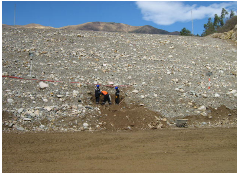
Foto 34: Presa Alpamarca – Demolición del dado de concreto que cubría el piezómetro de tubo abierto PA-12, para proceder luego a su recrecimiento (19/09/06).
