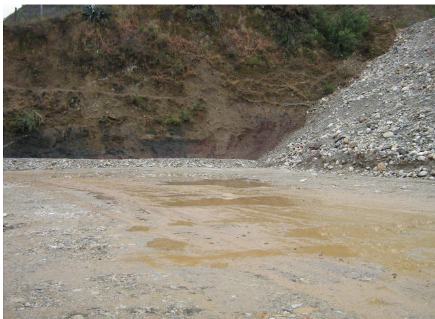
Foto 33: Presa Alpamarca – Colocación del material de dren alterno sobre el estribo derecho y adyacente a la zona de los aflojamientos de agua (18/09/06).
