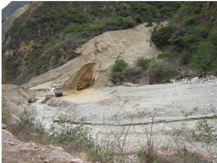
Foto 22: Vista del material arenoso en la quebrada Tacshana.
