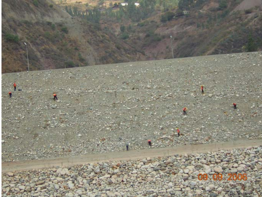
Foto 24: Presa Alpamarca – Limpieza y desbroce del talud aguas debajo de la presa Alpamarca (09/09/06).
