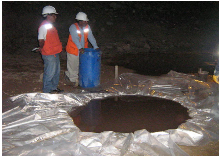
Foto 44: Presa Alpamarca – Ensayo de reemplazo de agua (densidad in situ) sobre el relleno principal de grava, cuarta capa (25/09/06).
