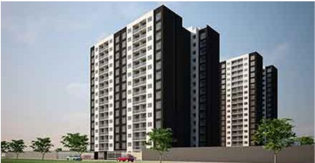
Imagen 15 – Terrazas de la Costanera - Fuente: AvG Constructora
