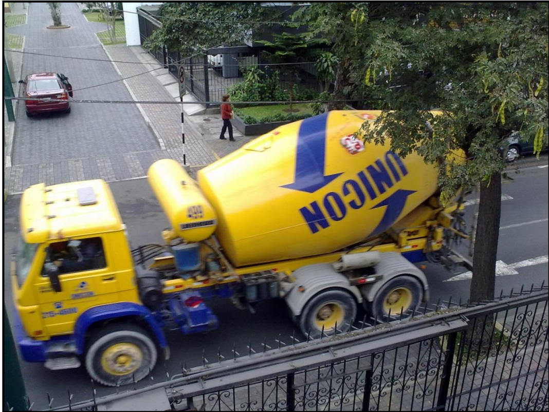
Figura 26: Transporte de cemento a las 11:25 horas.
