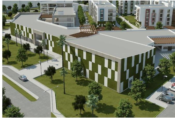
Se emplearán muros verdes en el proyecto para reducir la ganancia térmica y evitar el uso excesivo de energía para el confort en los espacios interiores.
