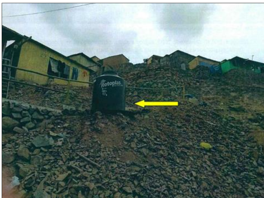
Figura N° 1. Viviendas construidas sobre pircas y tanques de almacenamiento para consumo.
