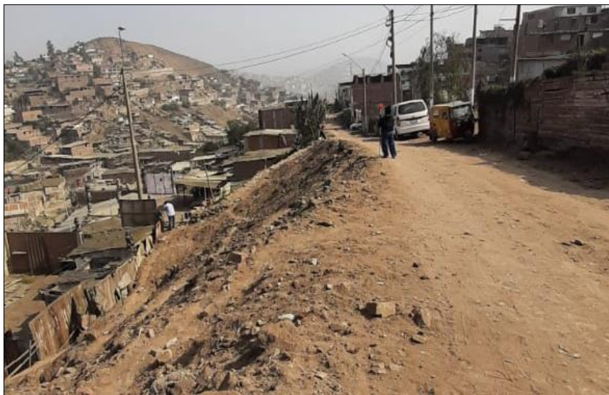
Figura 26. Visita de campo al AAHH 8 de Enero
