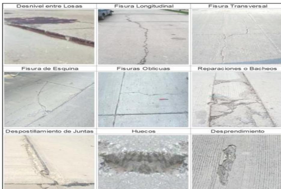
Figura 28. Daños en pavimentos rígidos.
