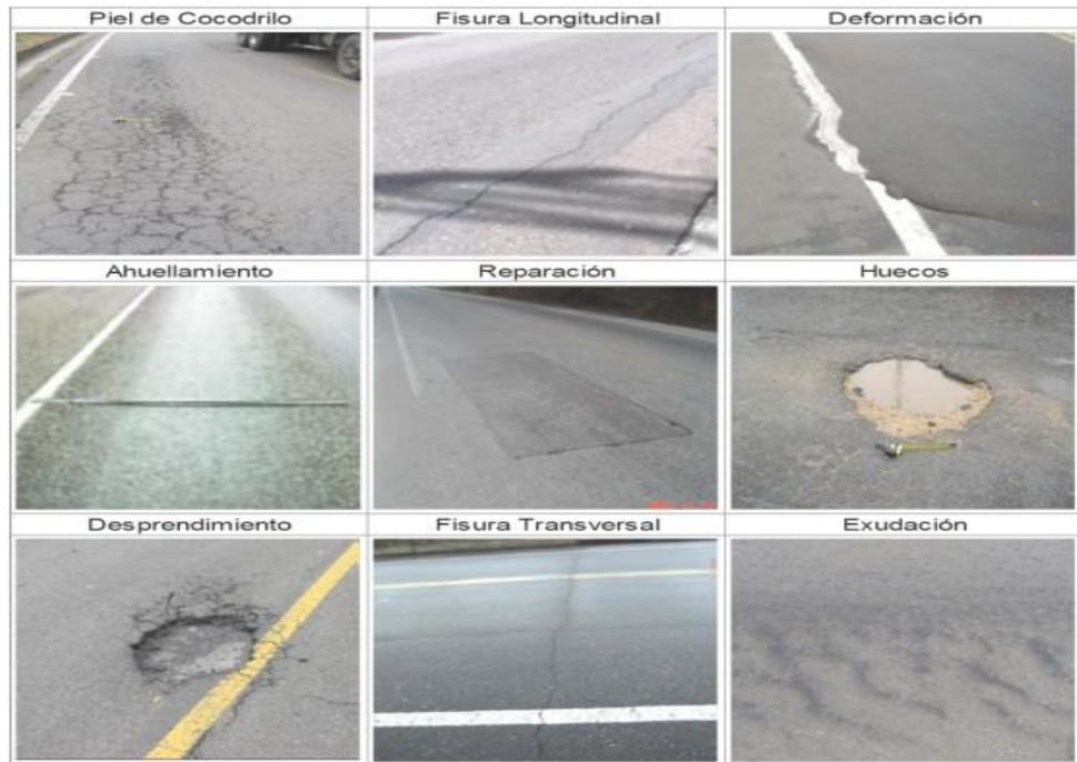
Figura 26. Daños en los pavimentos flexibles.
