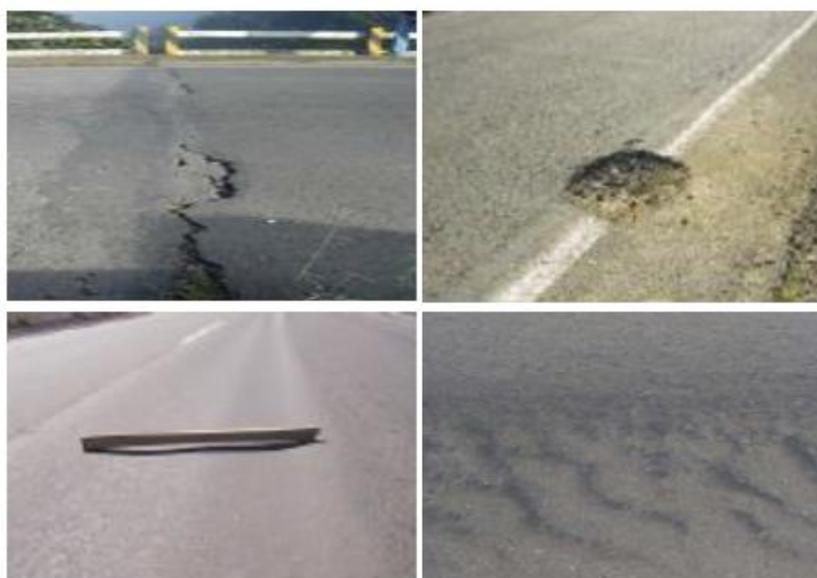
Figura 15. Fisuras, baches, ahuellamiento y exudaciones.
