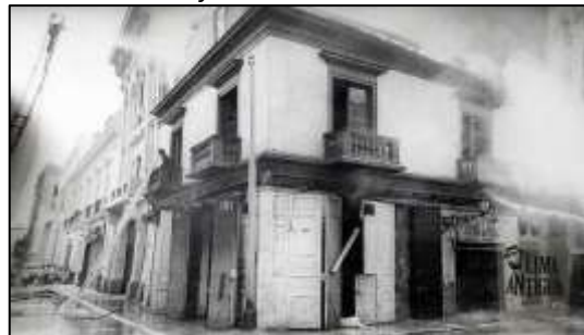
Figura 06 Incendio del edificio.
