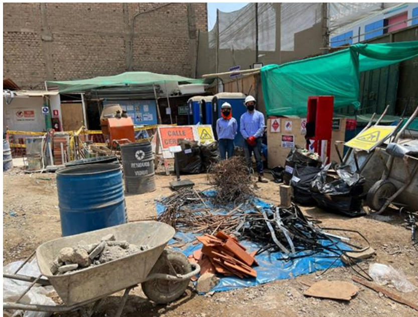
Figura 19. Segregación de los RCD.
