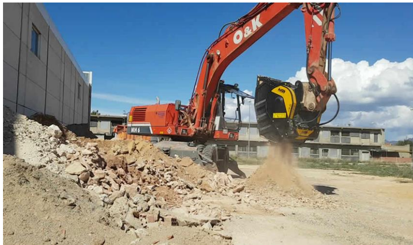
Figura 8. Etapa constructiva: demolición.
