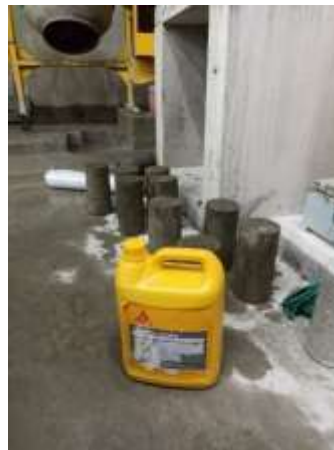
Foto 21: Aplicación del sanador químico.
