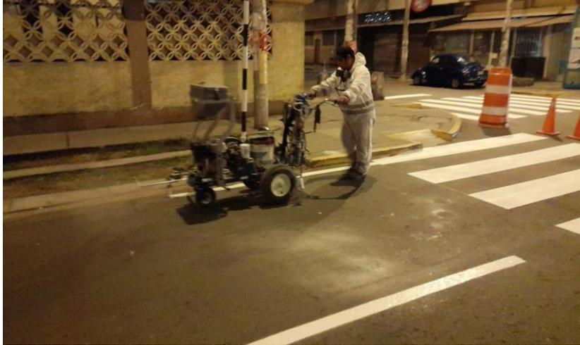
*Figura 11: Calibración de ancho de pintura*
