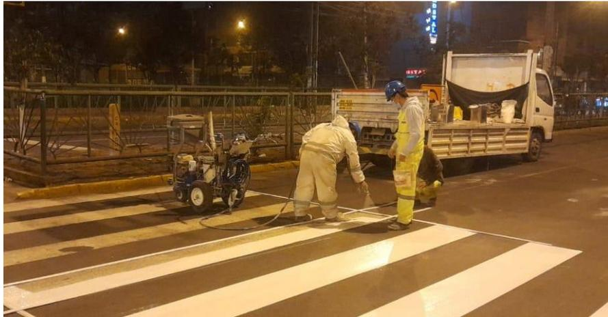
*Figura 14: Señalización en el pavimento*
