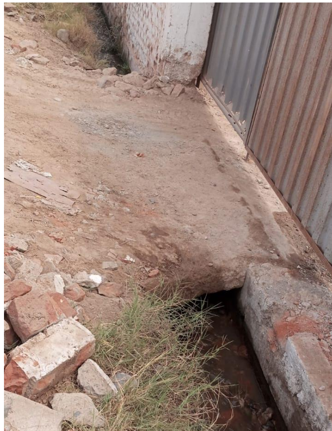
Anexo H: Condiciones espaciales del Proyecto Vivienda Centro Poblado La Molina 15121, Carabayllo: 1 acequia de 3 m al ingreso de la obra
