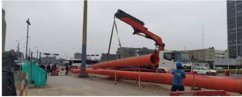
Figura 52: Izaje de tubería termo-fusionada Fuente: Elaboración propia
