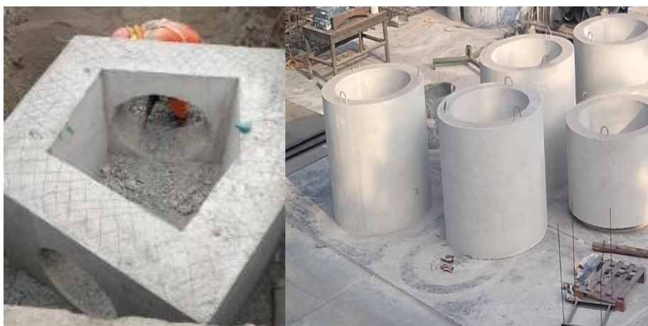
Figura 42: Piezas prefabricadas de buzón (cuerpo principal y cuerpo secundario)
