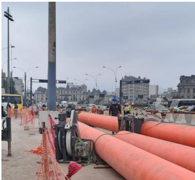
Figura 51: Termofusión de tuberías fuera de excavación Fuente: Elaboración propia
