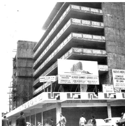
Figura 7 Construcción del Mercado Central
