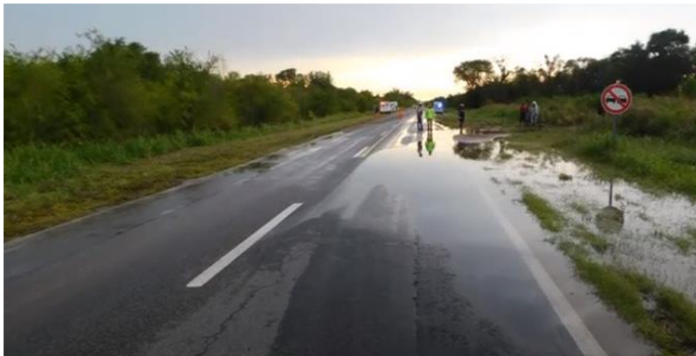
Figura 79. Pista mojada por lluvia.
