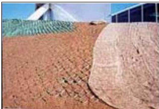
*Figura 30: Geoceldas cubiertas con una geomalla*
