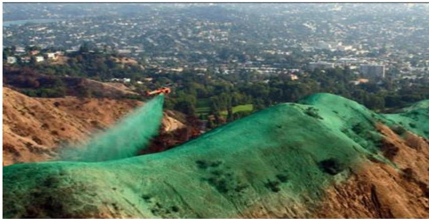
*Figura 12: Remediación mediante la técnica de la hidrosiembra*
