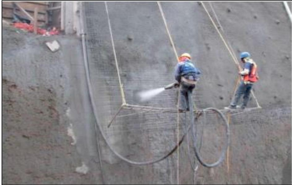
*Figura 21: Talud reforzado con concreto lanzado y malla electrosoldada*
