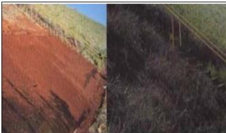
*Figura 28: Colocación de la geomanta, esparcimiento de semillas y cubierta de tierra*
