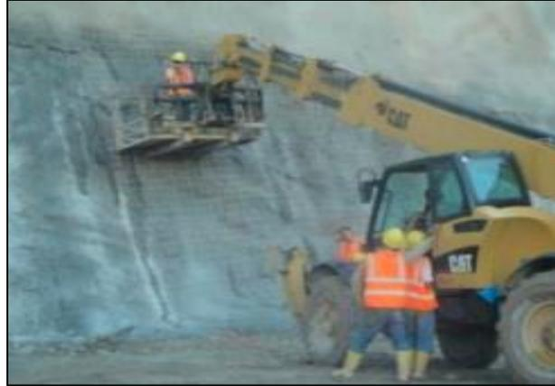
*Figura 22: Colocación de malla electrosoldada*
