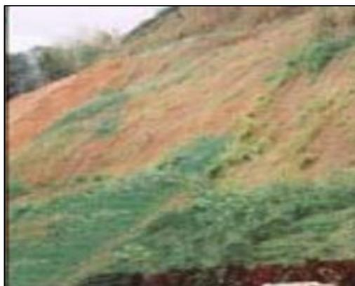
*Figura 24: Utilización de la biomanta*
