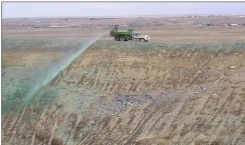
*Figura 11: Aplicación de las semillas sin acceder al talud*
