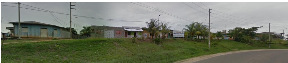
Figura 47: Vista de edificaciones frente al terreno 1 Año:2022. Recuperado de: Fuente propia
