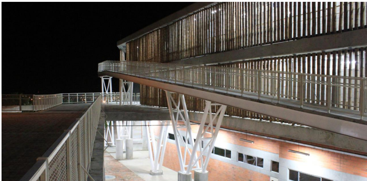
Figura 14: Rampa exterior - Institución Educativa la Samaria Año:2012 Recuperado de: https://www.archdaily.pe/pe/02-217687/institucion-educativa-la-samaria-campuzano-arquitectos
