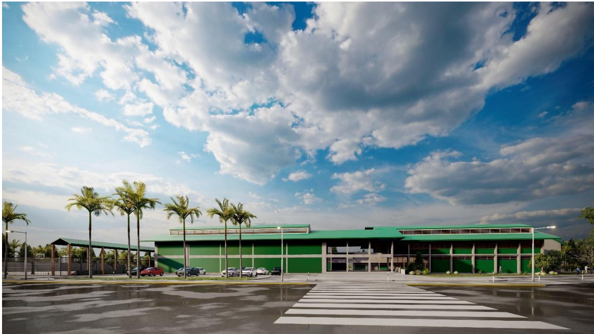
Figura 60: Vista Exterior Frontal Año:2022 Recuperado de: Elaboración propia
