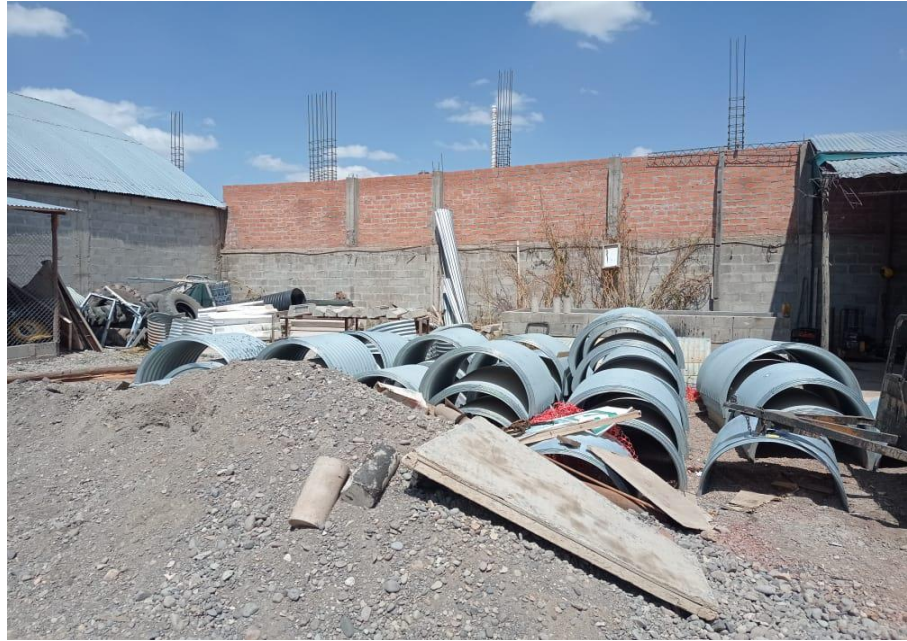
Figura 34: Desmonte de materiales Fuente: Elaboración propia
