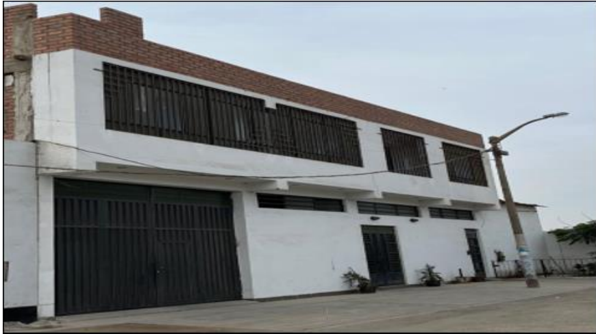
Figura 25: Fachada de la empresa Confecciones Adrianito SAC Fuente: Confecciones Adrianito SAC Elaboración: Elaboración propia
