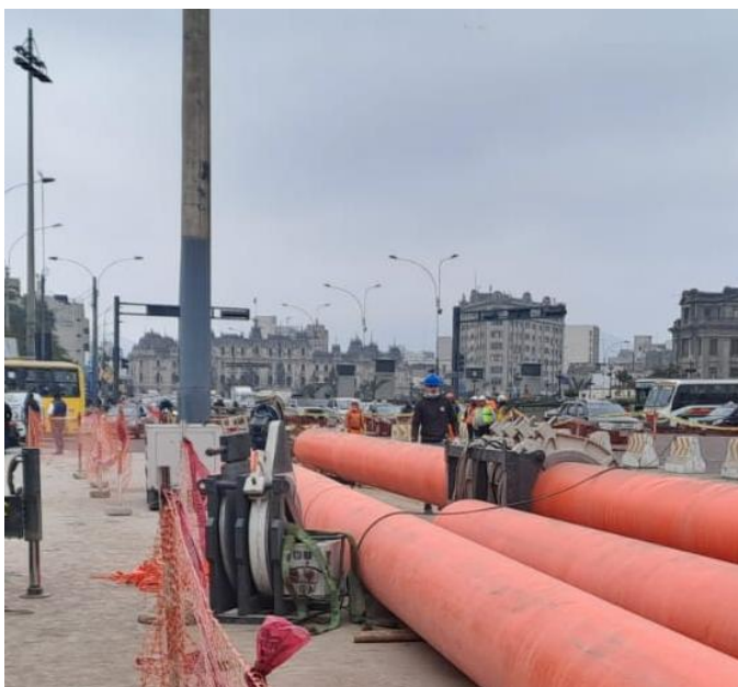
Figura 51: Termofusión de tuberías fuera de excavación Fuente: Elaboración propia
