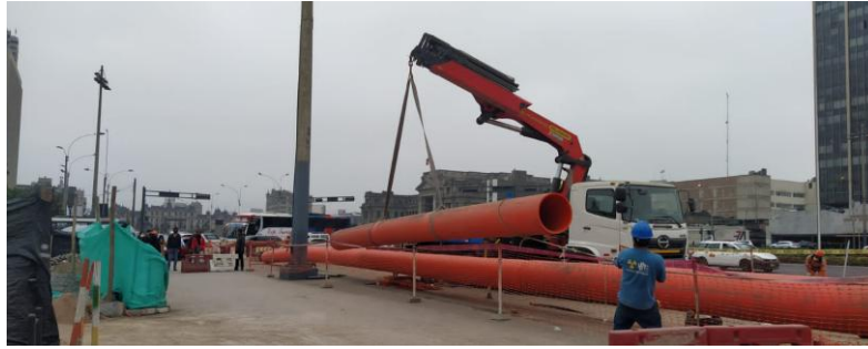
Figura 52: Izaje de tubería termo-fusionada Fuente: Elaboración propia
