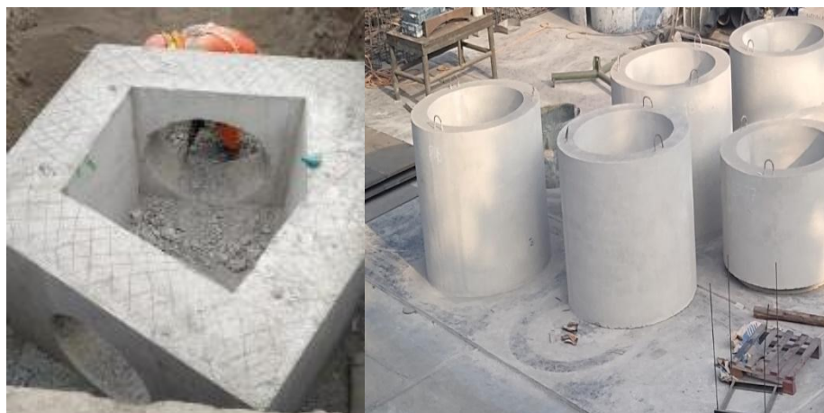
Figura 42: Piezas prefabricadas de buzón (cuerpo principal y cuerpo secundario) Fuente: Elaboración propia
