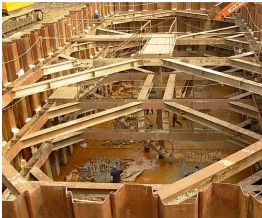
Figura 7. Imagen de sistema de entibado.
