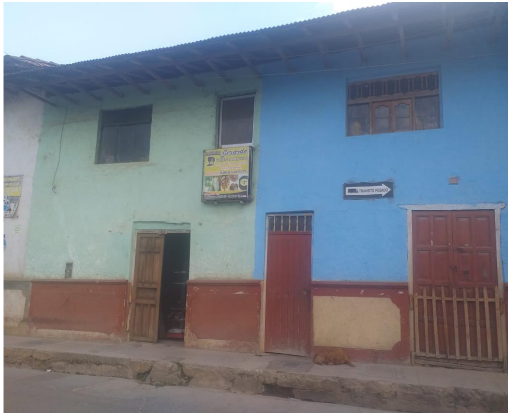
Figura 15: Fachada del negocio. Fuente: Elaboración propia
