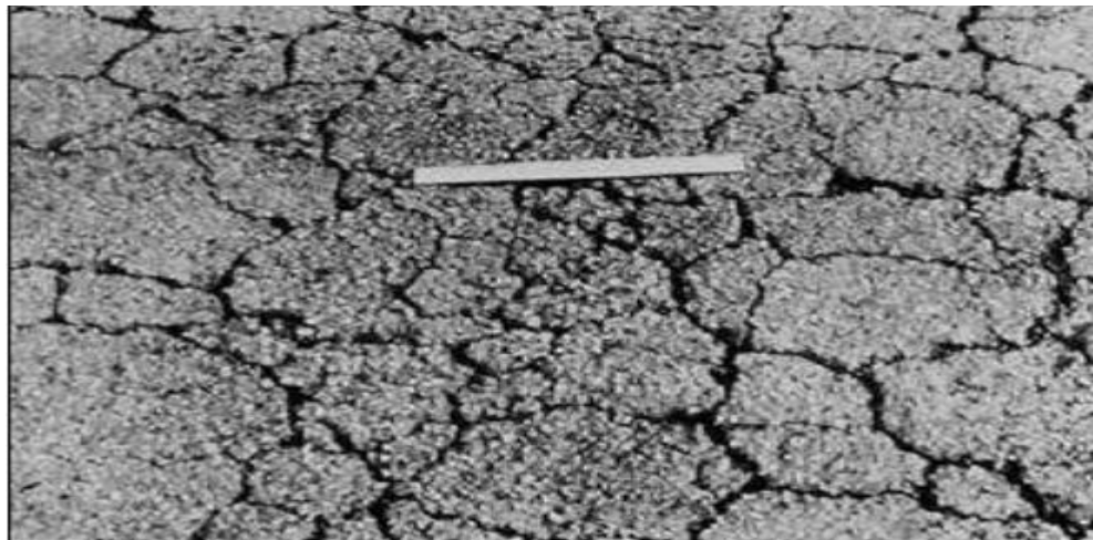
Figura 5: Piel de cocodrilo – Alta severidad. Fuente: Norma ASTM D6433-03 (2012)
