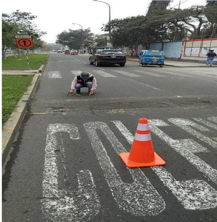
Figura 56: Inspección visual en campo. Fuente: Elaboración Propia.
